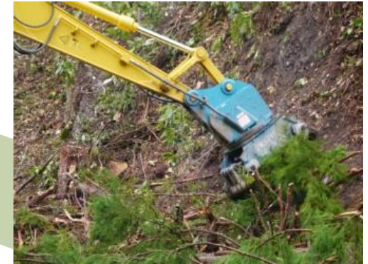
グラップルにより 林地を整理
