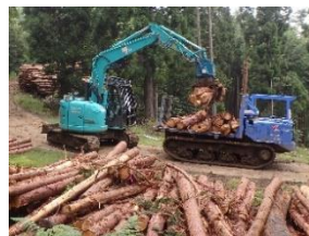
【中間土場での積卸作業】
