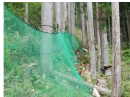
【安価なネットによるシカ柵の設置】 みやしろがわ (和歌山県すさみ町 宮城川国有林)
