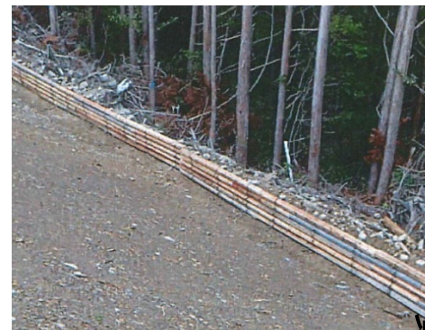
木柵工(0.2m 3 /m) 盛土のり尻に転石等の 流出防止のため施工
