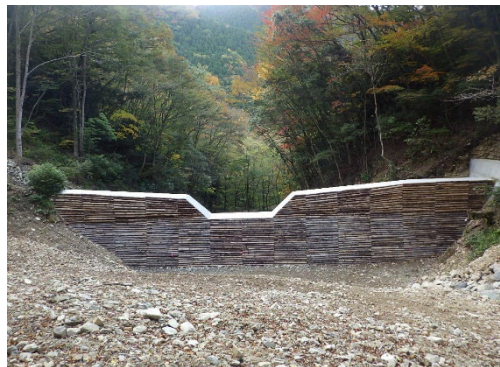
残存型柵工(0.12m 3 /m 2 ) 治山ダムの水表側に 丸太残存型柵を施工
