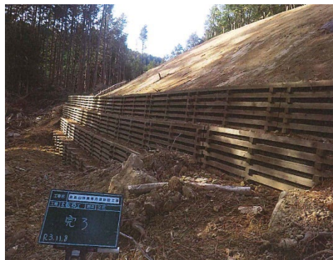
木製柵工(0.07m 3 /m) 盛土のり尻に木製柵 土留工を施工
