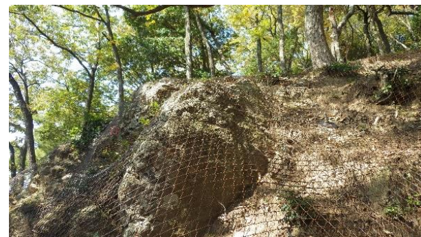
令和5年度山腹工施工地（旧城山国有林：鳥取市）
