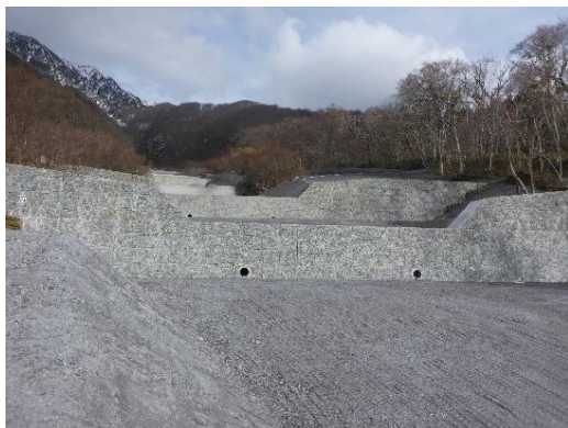
令和5年度床固工施工地（大山国有林：大山町）
