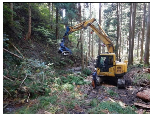
集材作業の様子 八川国有林(奥出雲町)
