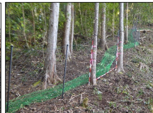
立木を利用した防護ネットの設置 艾山国有林（美郷町）
