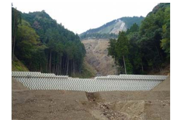
紀伊半島大水害から5年経過した復旧状況(和歌山県田辺市)
