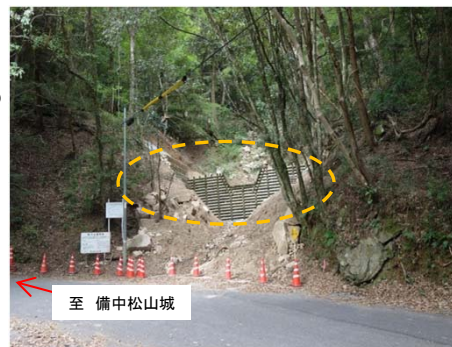
備中松山城に向かう市道を保全する治山ダムの設置(H28.10)
