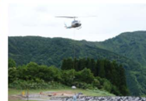
【ヘリによる施工状況】
