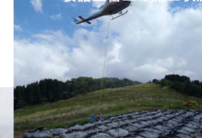
袋詰土留工の施工状況
