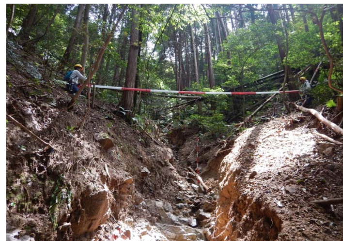
【復旧工事のための現地測量（H28,6月 広島署管内）】
