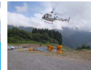
【ヘリによる施工状況】
