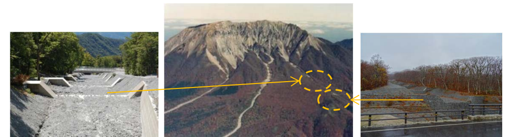
床固工群と護岸工により土砂を安全に流す対策を実施
