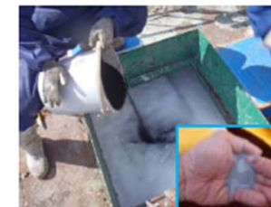
【侵食防止工資材の作製状況】
