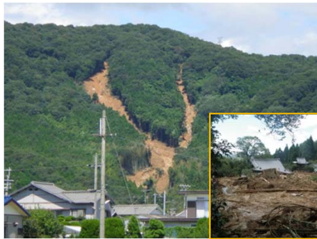
山腹崩壊により寺院や福祉施設が被災
