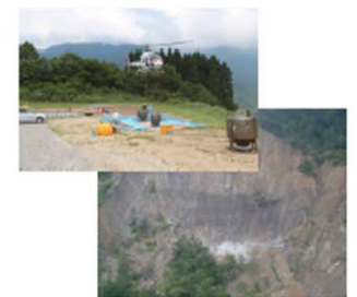
【（2）ヘリによる吹付状況（右写真は完了後）】
