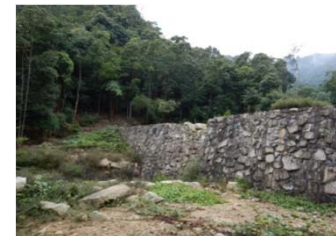
宮島土石流災害を受け景観に配慮した治山ダムを設置(H19)
