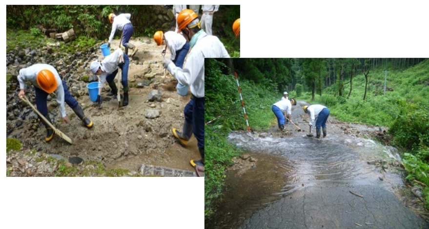
【応急的な土砂撤去（H27,7月京都所、H26,8月広島北部署）】
