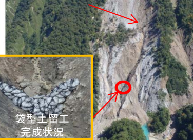
【緊急対策の完了時の状況(H27.10)】
