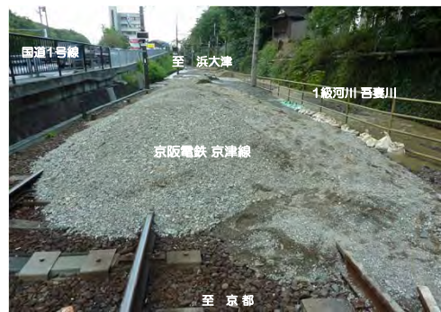
大津市逢坂（左写真の約800m下流） 京阪電鉄線路へ土砂が流出
