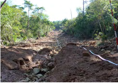
近江八幡市大中町 奥島山国有林 山腹崩壊し、下流の牧場へ土砂が流出
