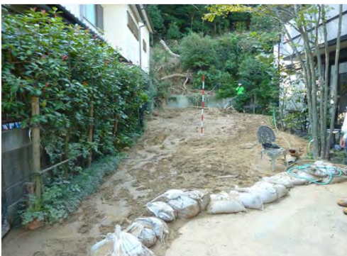
大津市大谷町 大谷国有林 上部の国有林から下流の人家へ土砂が流出
