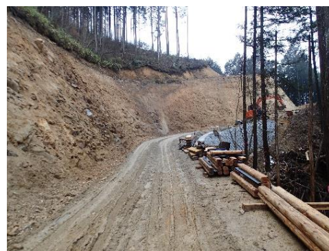
【林業専用道新設中】
