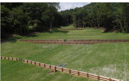
【加賀山（かがやま）山腹工】
