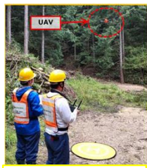
UAV調査状況
