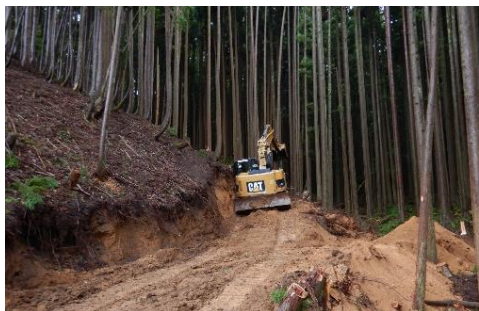
【森林作業道作設】
