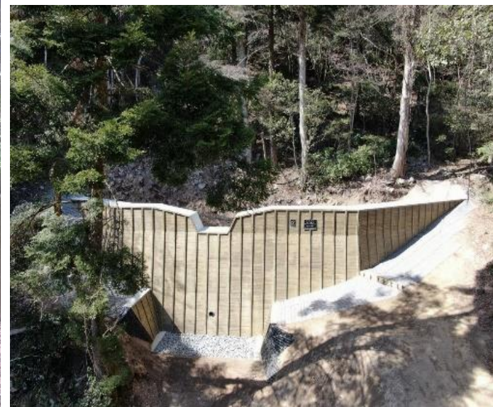
【木製残存型枠を使用した治山えん堤】
