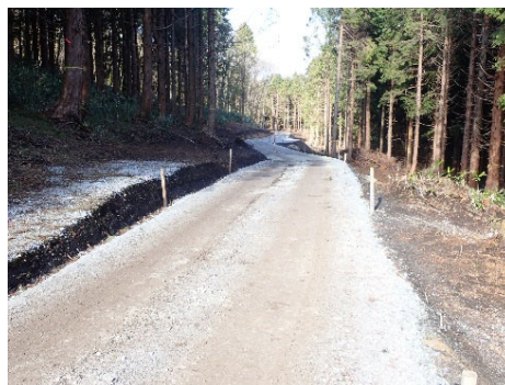
【林業専用道新設】
