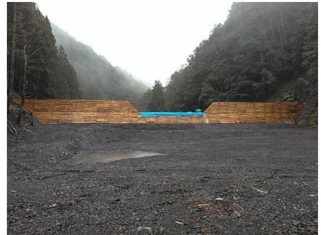
【間伐材を使用した丸太残存型枠】 いまにし (吉野郡十津川村 今西工区)
