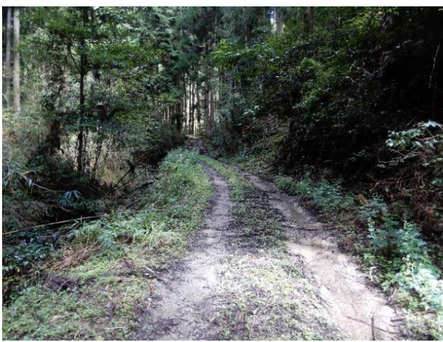
【林道整備前の状況】
