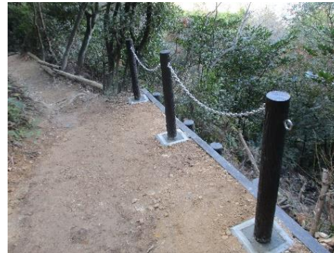
【大和三山風景林 歩道整備】 うねびやま (橿原市 畝傍山国有林 R6.1 完成)
