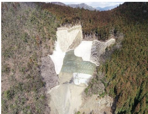
【山腹工施工状況】
