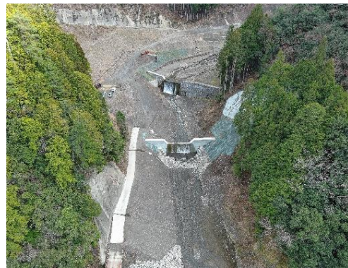
【溪間工施工状況】
