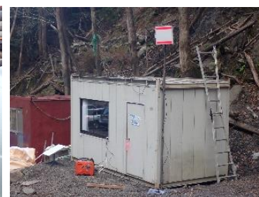
Starlink 地上アンテナとWi-Fi パッケージ 設置状況
