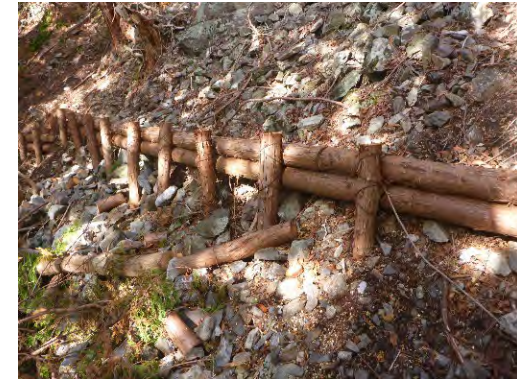
【間伐材を使用した丸太筋工】
