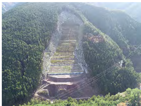
【山腹工施工状況】
