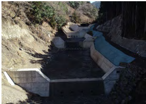
【溪間工施工状況】
