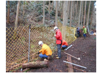
シカ防護柵の補修
