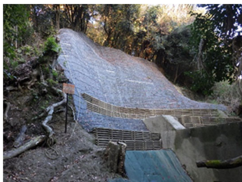
木製枠筋工の設置(遠景)
