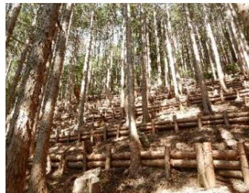
間伐木を筋工に利用した保安林の整備 (和歌山県田辺市 公門谷国有林)
