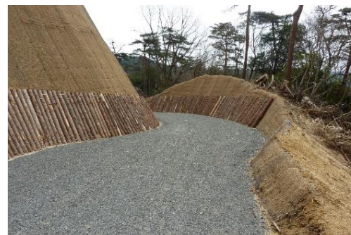
工事支障木を利用した丸太伏工 こうかし さんごうやま (滋賀県甲賀市 三郷山国有林)
