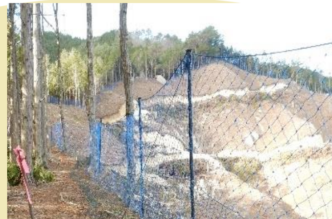
立木を活用したシカ防護柵 つやまし つかわやま 岡山県津山市 津川山国有林
