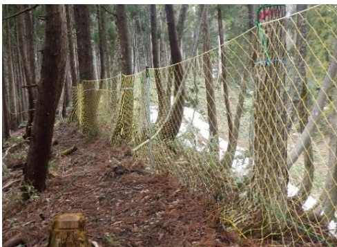
立木を支柱として活用した防護柵 くらよしし にしがも (鳥取県倉吉市 西鴨国有林)
