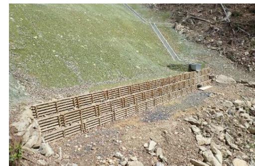
木製枠を用いた法尻基礎工 くめぐんみさきちよう だいとやま (岡山県久米郡美咲町 大戸山国有林)
