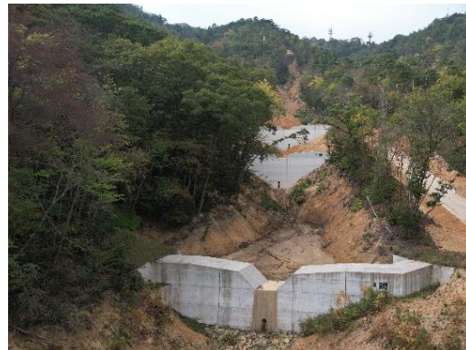
平成30年7月の集中豪雨により被災した箇所の復旧状況 (広島県東広島市 東広島地区民有林直轄治山事業地)
