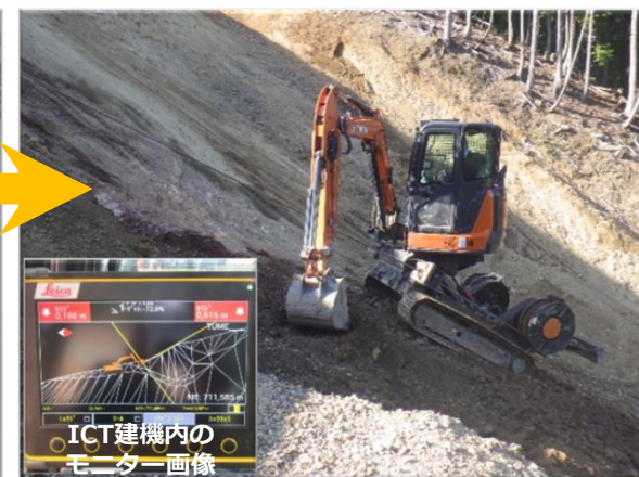
山腹斜面の3次元設計データ（ドローン測量）を用いたICT建機による掘削作業事例
