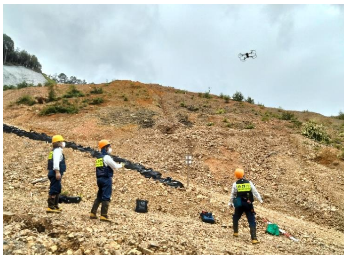
ドローンを活用した被災状況調査
