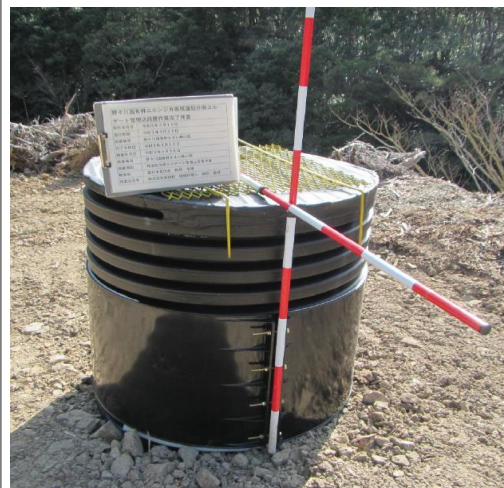
埋設した大型排水管
