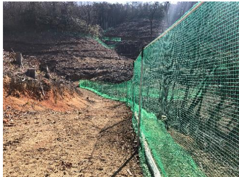
低コスト資材を活用した防護柵 (岡山県久米郡美咲町 大戸山国有林)
