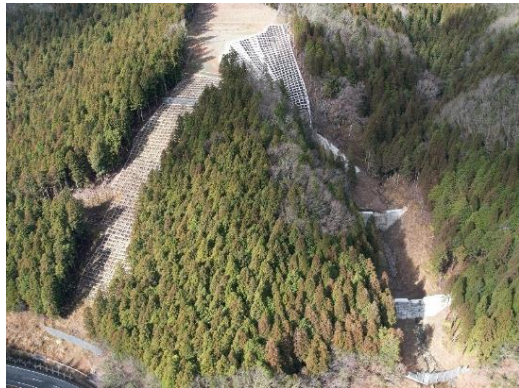
平成30年7月の集中豪雨により被災した箇所の復旧状況 (兵庫県粟粟市 戸倉東山国有林)
