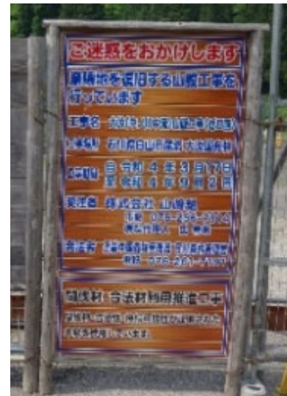
【木製の工事看板】 おおなんじ (石川県白山市 大汝国有林)
