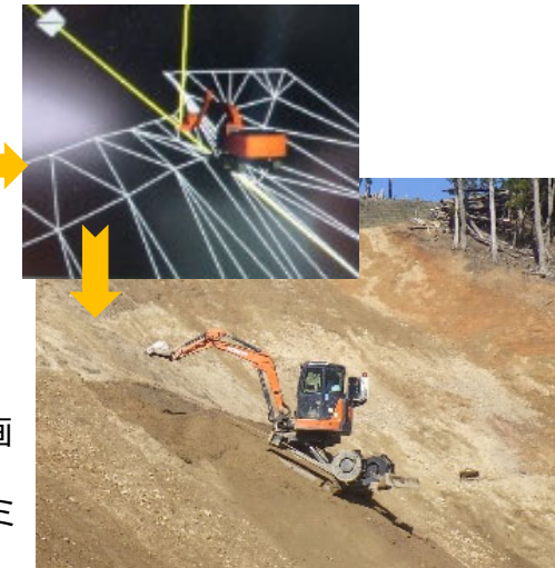
【ICT (RCM) 法面掘削】
