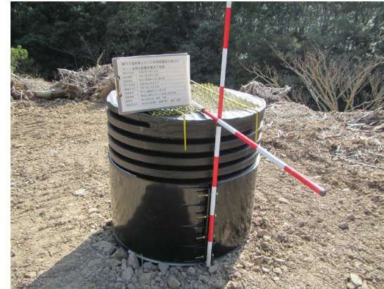
埋設した大型排水管
