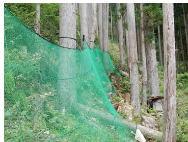
【低コスト資材を活用した防護柵】 みやしろがわ (和歌山県すさみ町 宮城川国有林)
