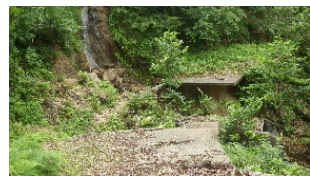
【林道改良箇所】
