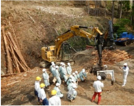
【製品生産現場の現地視察】 あかさい (兵庫県宍粟市 赤西国有林)
