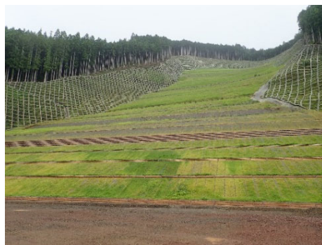
【山腹工】 (奈良県天川村 十津川地区：坪内)
