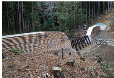
【赤羽川上流域の治山対策（流木捕捉式治山ダム）】 かじやまた 鍛冶屋又国有林) (三重県紀北町
