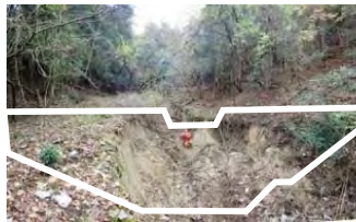
【治山ダム予定箇所】 三重県伊賀市 入丸国有林(三重署)
