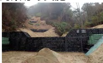
【治山ダムによる不安定土砂の固定】 滋賀県竜王町 竜王山国有林(滋賀署)
