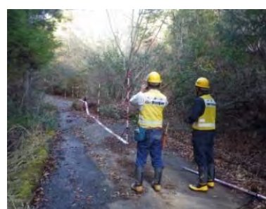
【民有林林道の被害状況調査】
