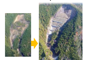
【被災直後の状況】
