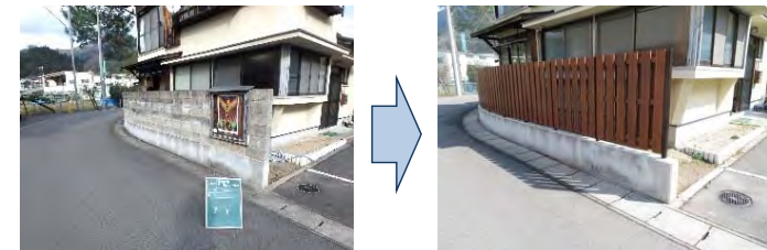
施工前 加計森林事務所 施工後 広島県安芸太田町(広島署)
