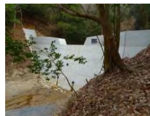
【治山ダムの整備状況(H30)】
