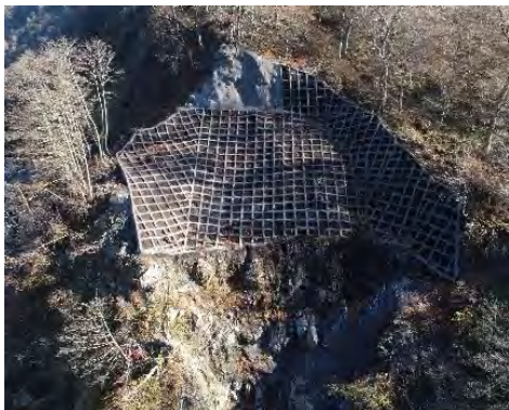
山腹工 (白山市 手取川地区:湯の谷)
