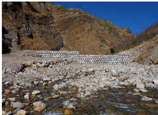
溪間工 (白山市 手取川地区:湯の谷)
