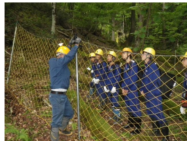
さかのたに 中学生によるシカ防護柵修理実習 【坂ノ谷国有林（宍粟市）】
