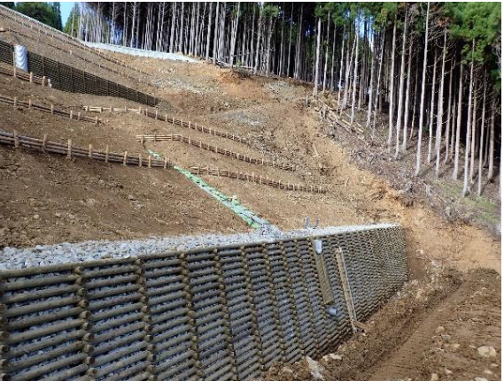
令和6年度施工 木製校倉式土留工 あぜくら あじやり 【阿舎利国有林（宍粟市）】
