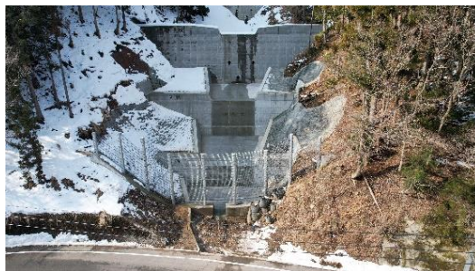
令和6年度施工 治山ダム工 とくらひがしやま 【戸倉東山国有林（宍粟市）】
