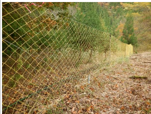
上張りワイヤーの防護柵 【マンガ谷国有林（宍粟市）】
