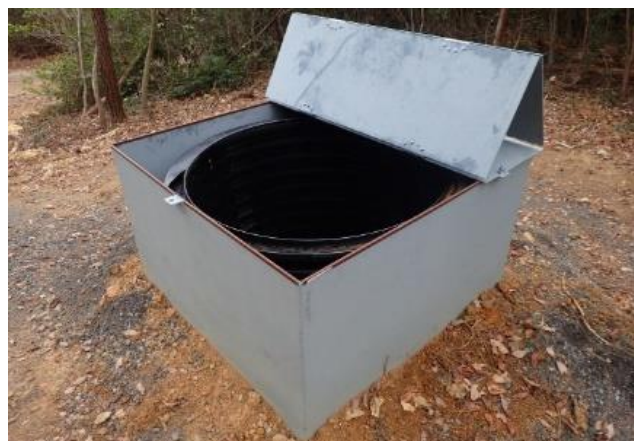
大型排水管を活用したシカ埋設処理施設 【新宮滝谷国有林（たつの市）】
