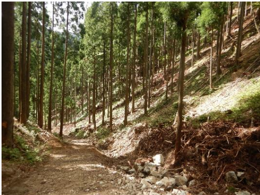
森林作業道作設後の様子 【 あかさ 赤西国有林（宍粟市）】
