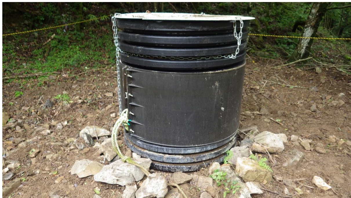
写真：和歌山森林管理署で実証試験中の大型排水管の埋設状況
