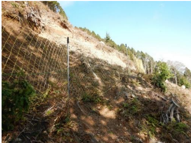
上張りワイヤーの防護柵 【有ケ原国有林（宍粟市）】
