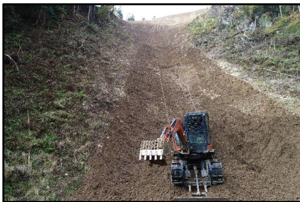
高所法面掘削機械による掘削
