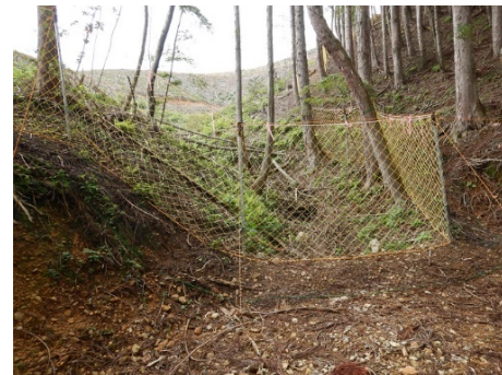
飛び越え防止ロープ付き防護柵 (河原山国有林)
