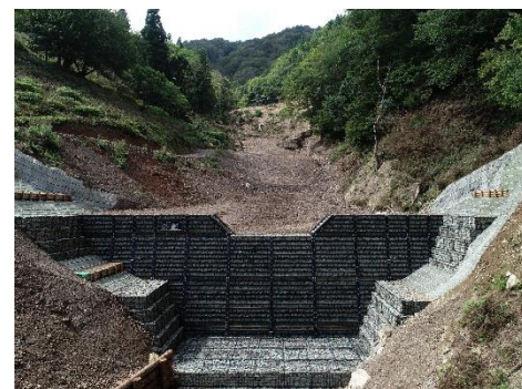
令和6年11月竣工 河内溪間工事 (若狭町 河内国有林)
