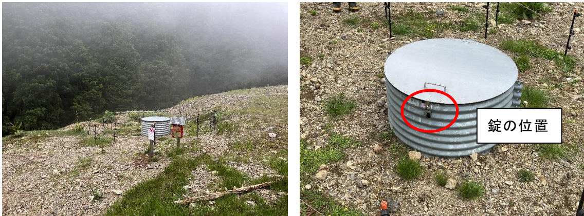
図 2-5 大型排水管（左：遠景、右：錠の位置）
