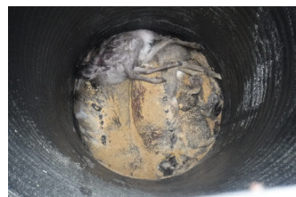
大型排水管の内部
