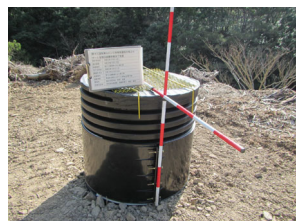
埋設した大型排水管
