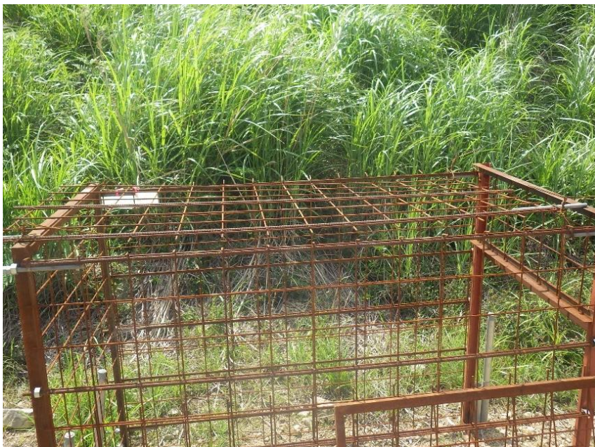
写真8 こじゃんと2号の天井部の処理状況
