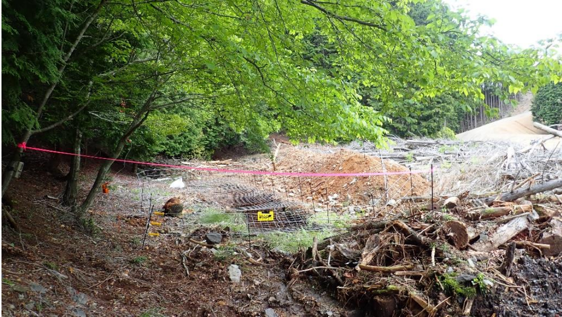
写真 16 埋設穴①（いなべ市）に設置した埋設穴の掘削状況と柵の設置状況
