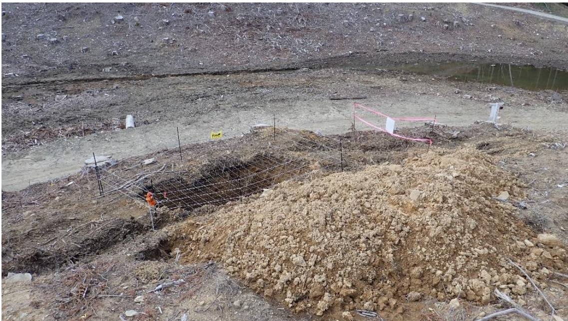
写真 17 埋設穴②（桑名市）に設置した埋設穴の掘削状況と柵の設置状況②
