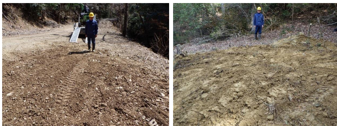
写真5. 埋設穴埋め戻し後の状況
