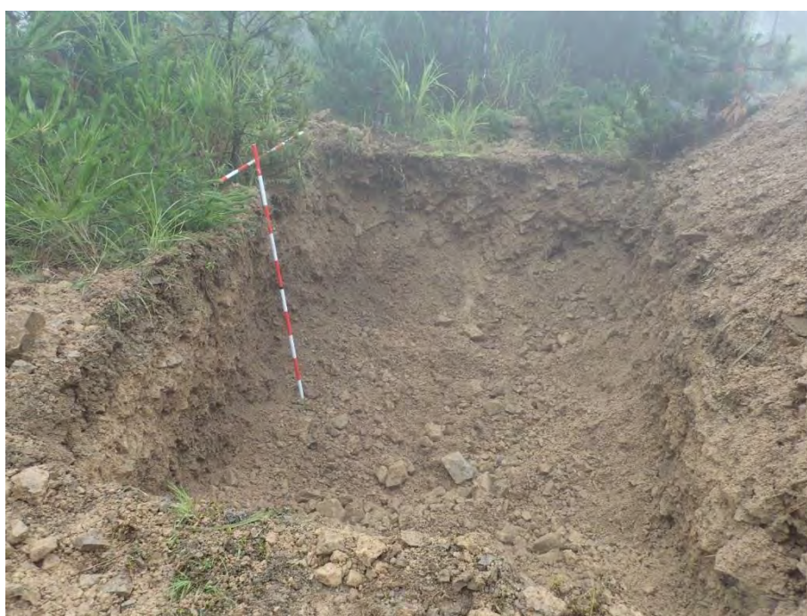
写真 20 埋設穴の掘削状況
