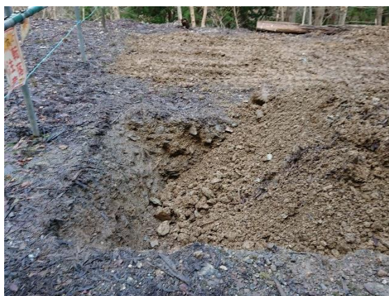
写真 3-4-5 埋め戻し途中（1月23日）
