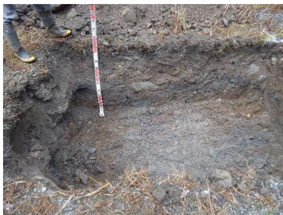
写真 3-4-1 掘削した穴（岩瀨）
