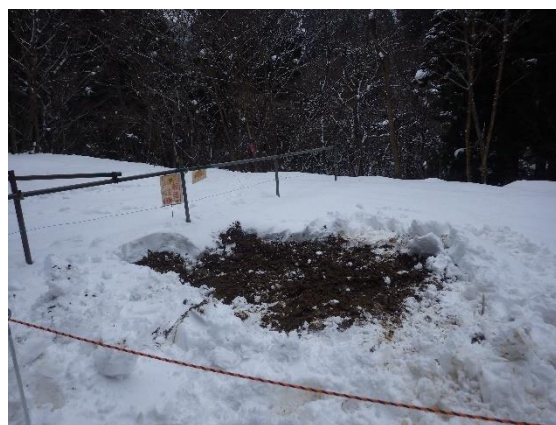
写真 3-4-6 埋め戻し終了（1月29日）
