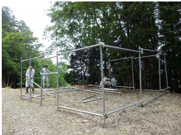
骨組みの組み立て作業
