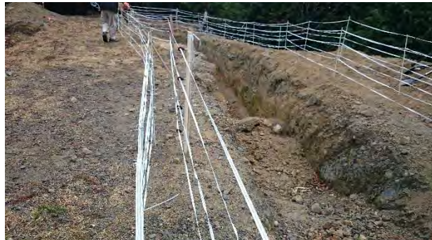
二重張り設置②
