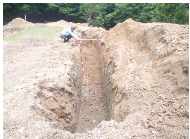
掘削後（埋設穴）
