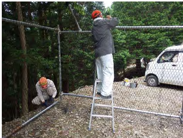
スーパーPK ネットの設置
