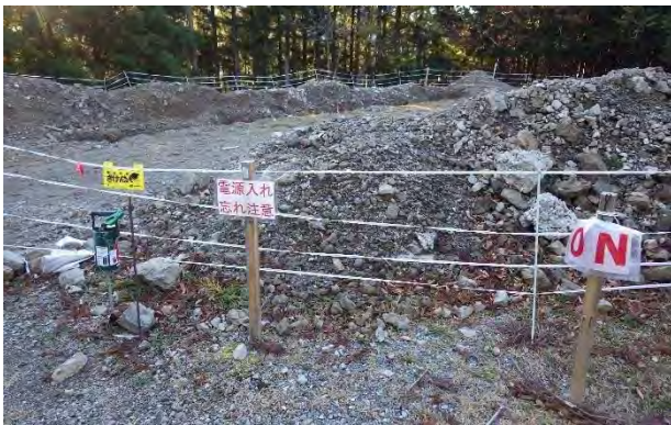
電源入れ忘れ防止用看板の設置
