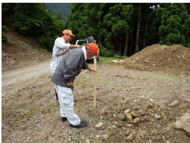
杭の打ち込み
