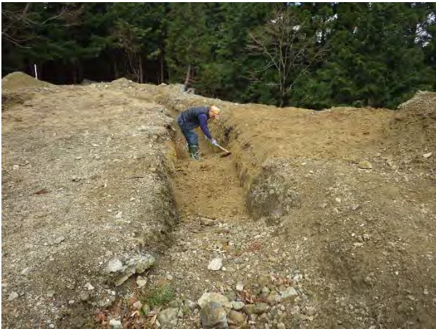
土入れ作業風景
