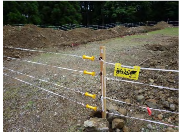
設置後（出入口）
