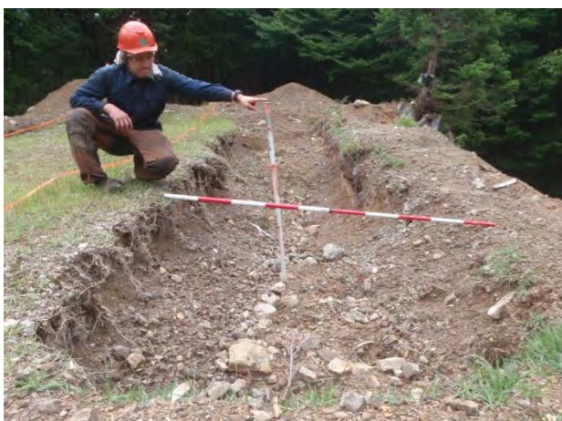
掘削前（埋設穴）
