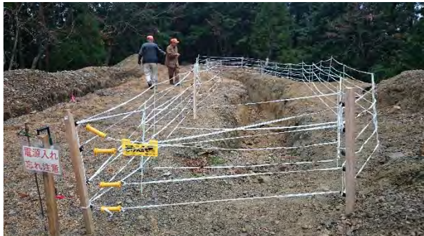
二重張り設置①
