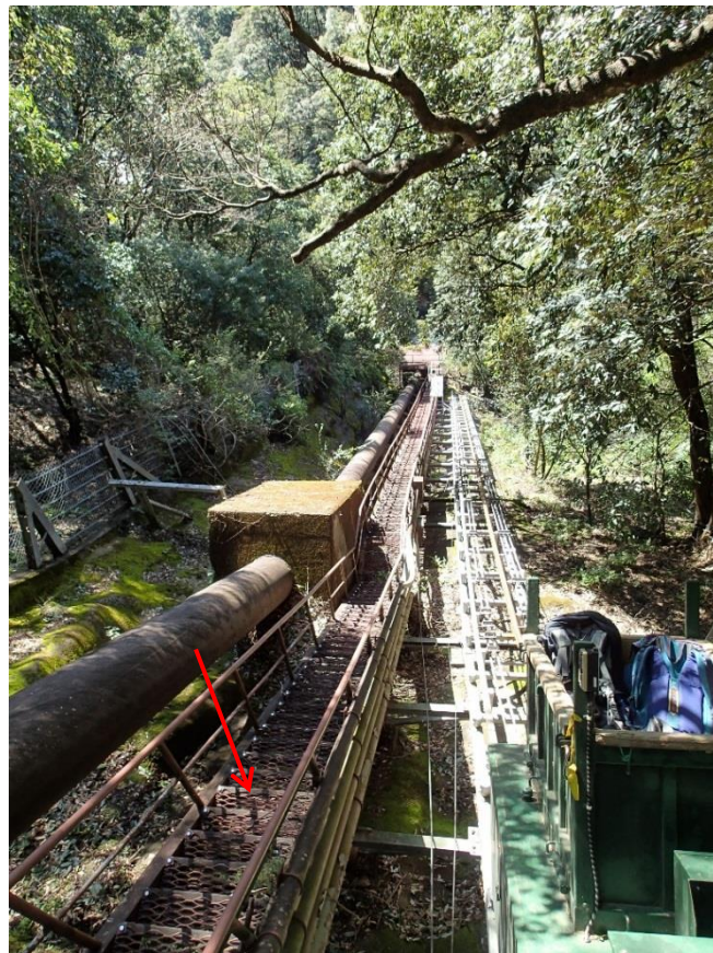
写真 12 モノレールから地点①を見下ろした様子 (赤矢印が管理用の階段、平成 29 年 10 月 26 日)
