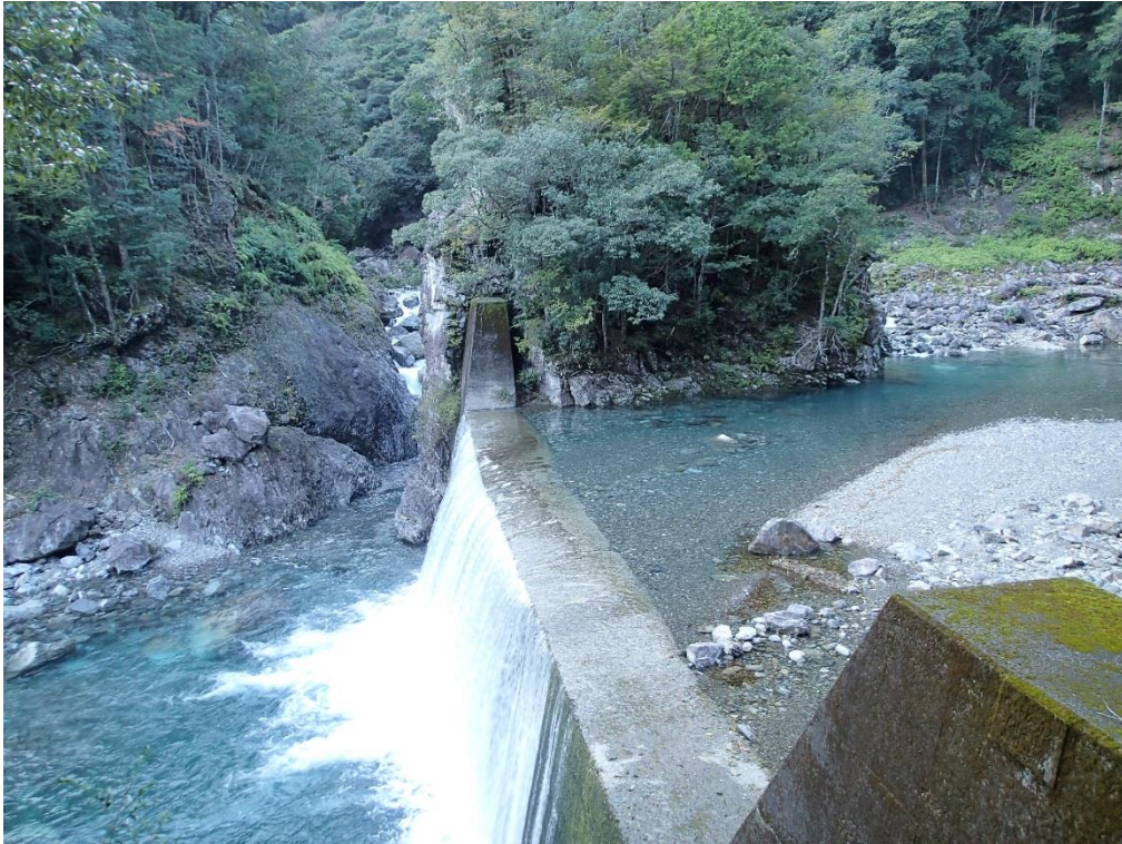
写真1 図3の地点①の堰堤の様子（堰堤の東側より撮影） 平成29年10月27日
