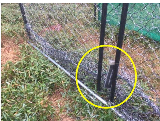
図 3-3 法令上定められた標識の取り付け
