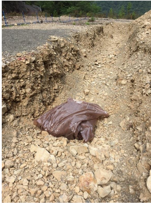
図 3-9 生分解性ガスバリアシートを使用した埋設
