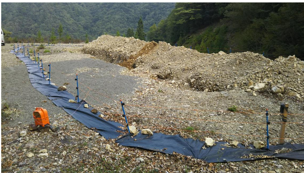
図 3-10 電気柵の設置
