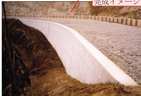
カンカケ三室林道改良工事 赤西国有林
