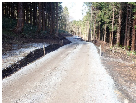
【林業専用道新設】
