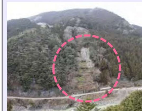
堂平工区（被災直後） ・地すべり兆候の規 3.00ha ・対策：アンカー工 (令和3年度工事完了・移管済)
