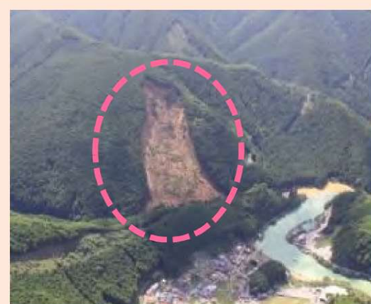
坪内工区（被災直後） ・崩壊規模 3.65ha ・対策：床固工及び山腹工
