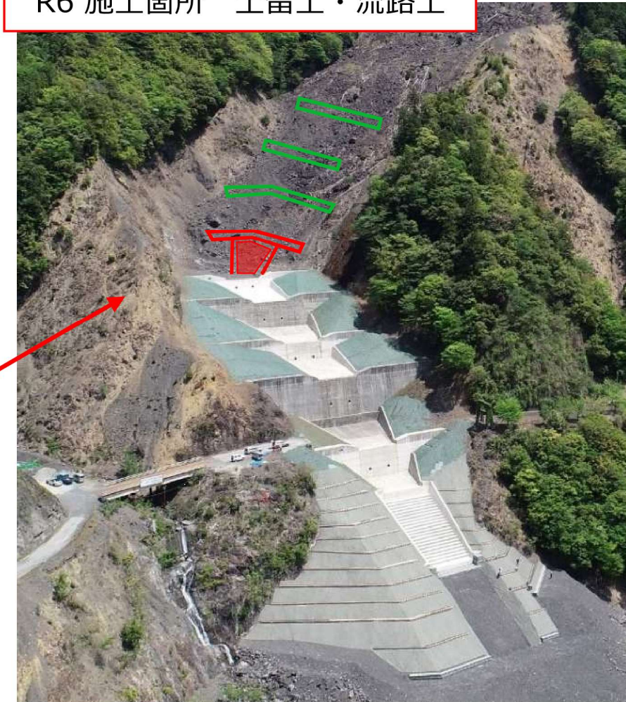
R6 施工箇所付近 (R7.5月)
