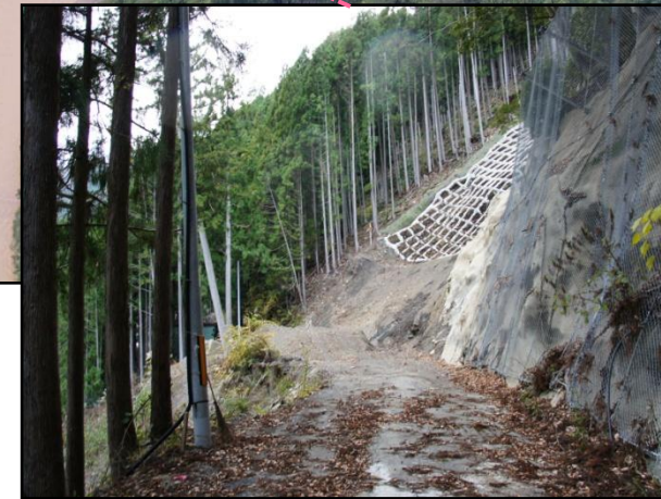
施工箇所下部状況
