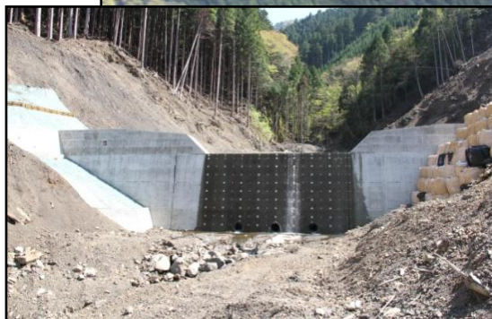
第4号谷止工 完成状況
