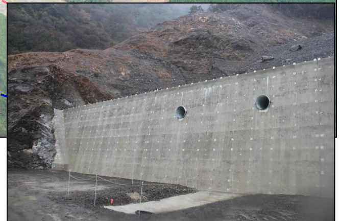
第2期谷止工事 完成状況
