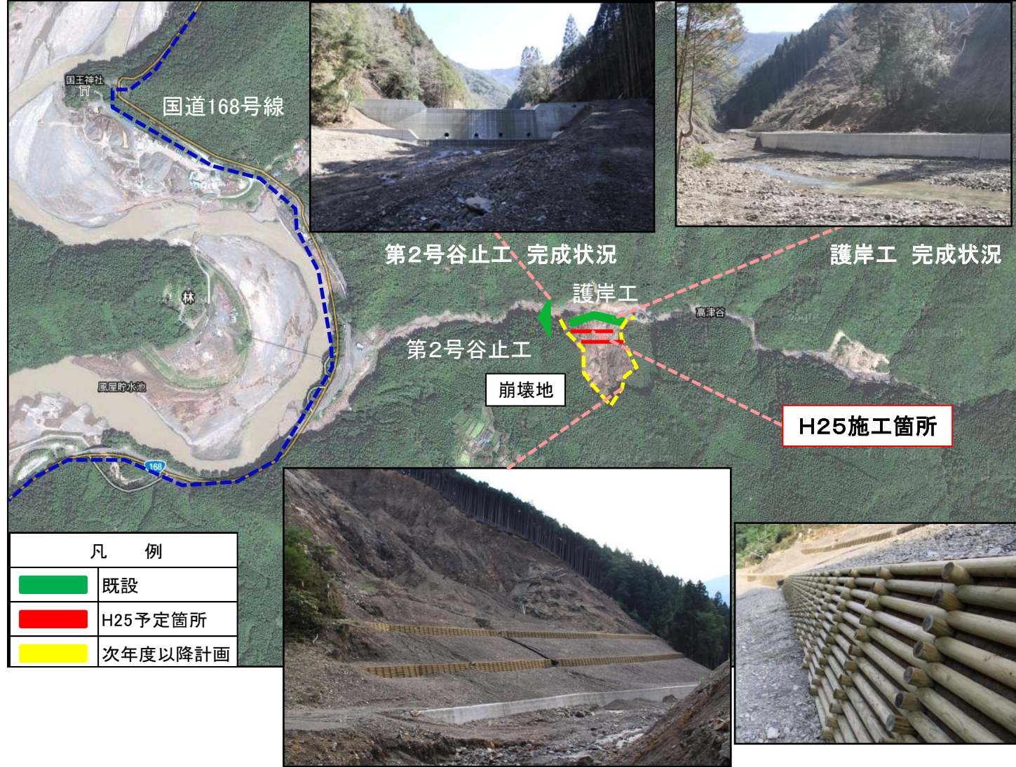
木製土留工 完成状況
