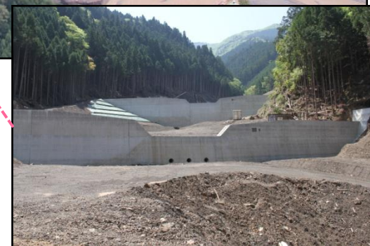
第2号谷止工 完成状況
