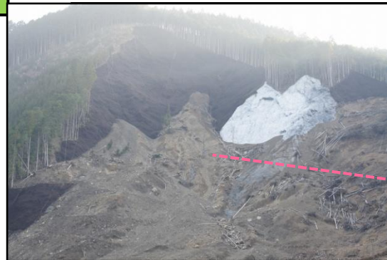
山腹工 完成状況
