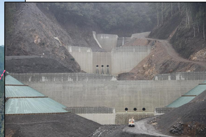
第1～3号谷止工 完成状況
