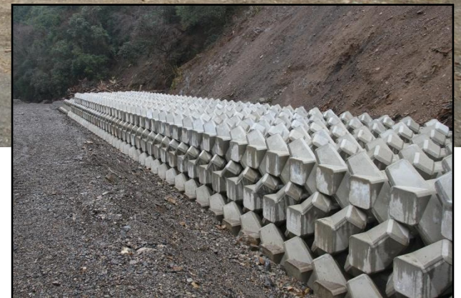
護岸工 完成状況(上流より)
