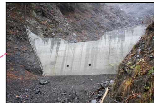
第3号谷止工 完成状況
