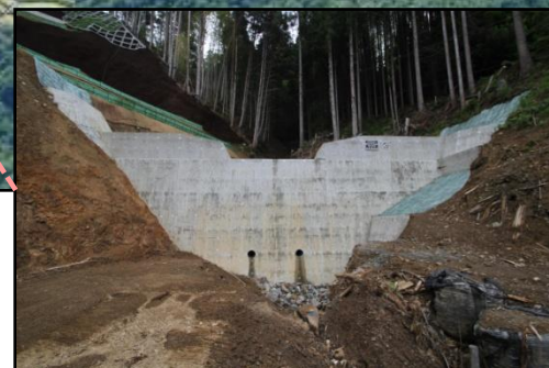
第1号谷止工 完成状況
