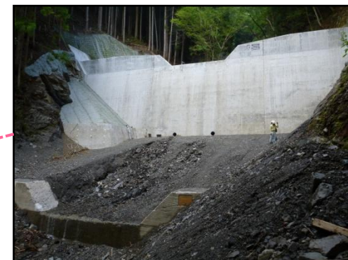
第2号谷止工 完成状況
