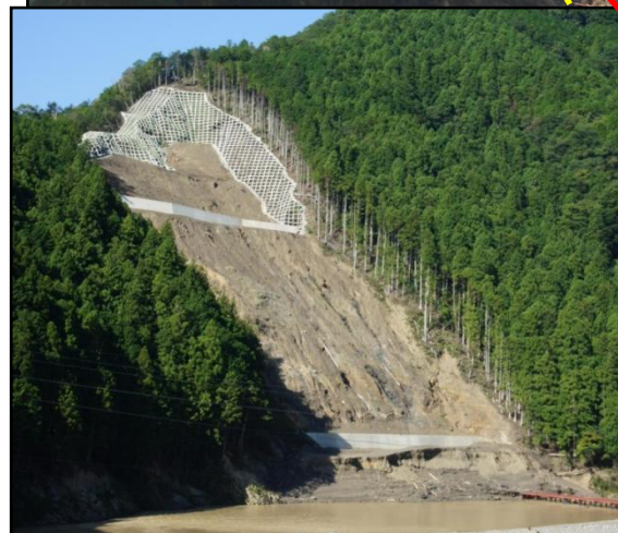
NO.1、NO.2土留工 完成状況
