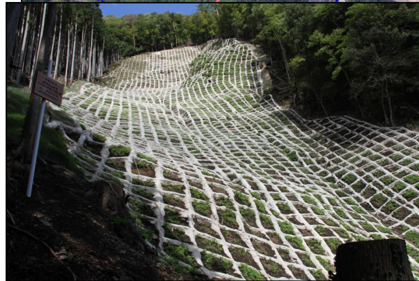
山腹工 完成状況
