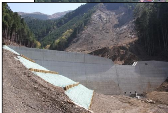
第3号谷止工 完成状況
