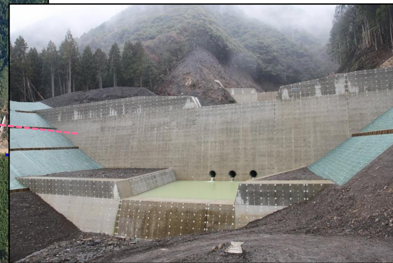
第1号谷止工 完成状況
