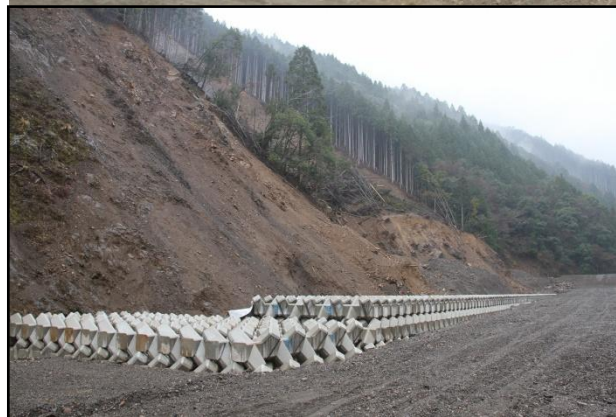
護岸工 完成状況(下流より)
