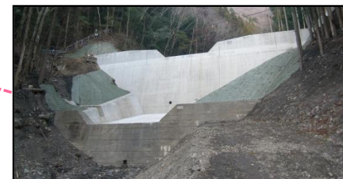
第1号谷止工 完成状況
