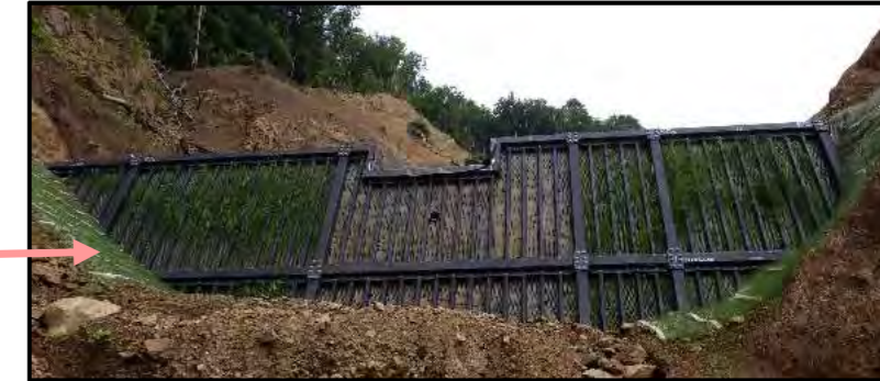
6号鋼製土留工 完成状況
