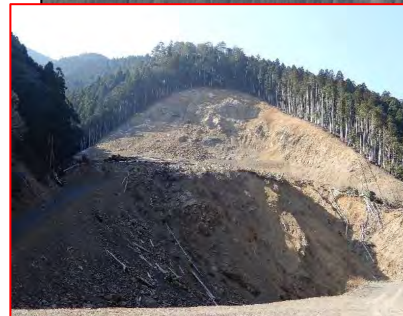
排土工 完成状況
