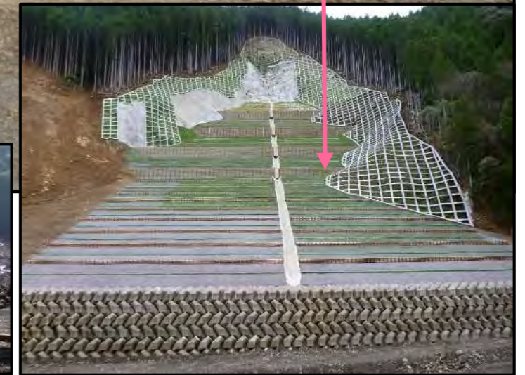
法枠工・木柵・筋工 完成状況
