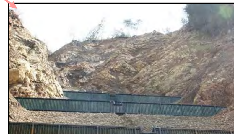
3号、4号鋼製土留工 完成状況
