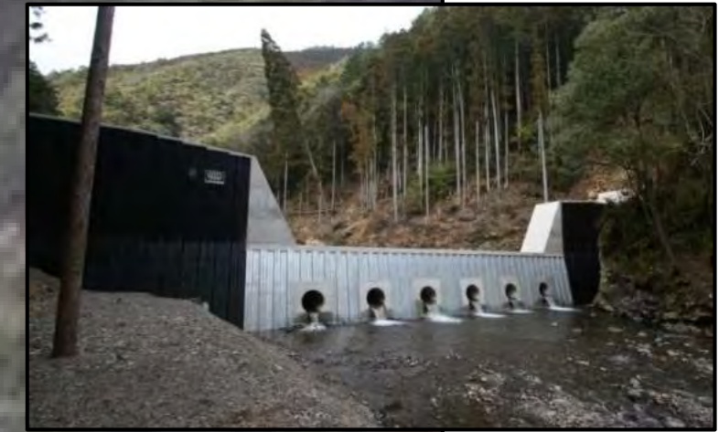
鋼製谷止工 完成状況
