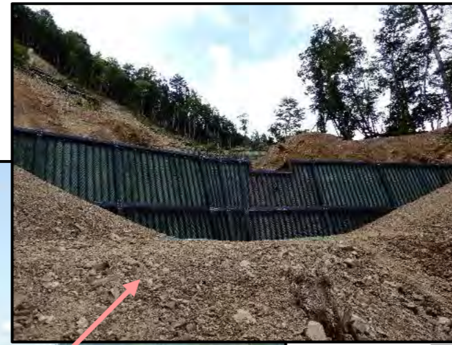
7号、8号鋼製土留工 完成状況
