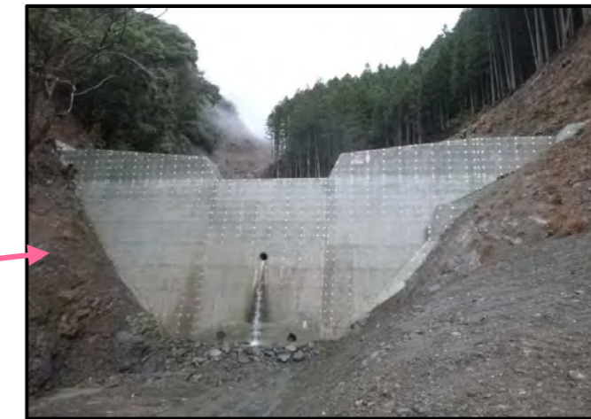
第4号谷止工 完成状況
