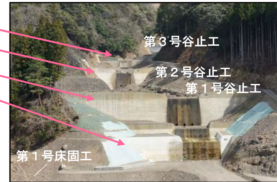
第1～3号谷止工 第1号床固工 完成状況
