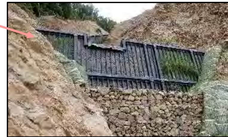
5号鋼製土留工 完成状況
