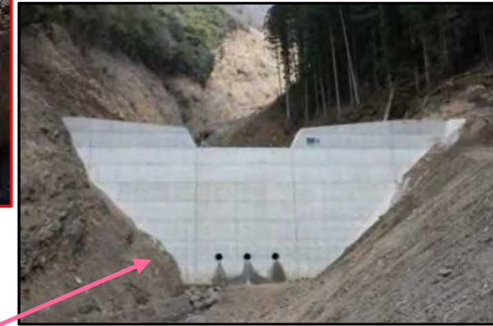
第5号谷止工 完成状況
