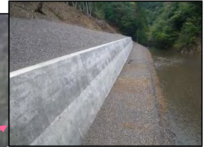
護岸工 完成状況
