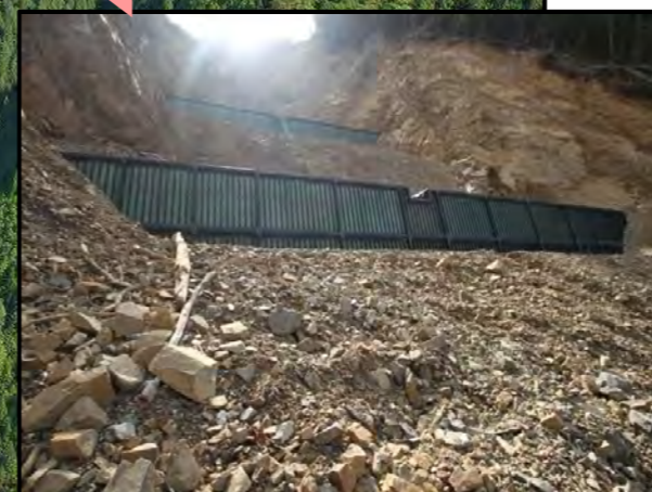
1号、2号鋼製土留工 完成状況
