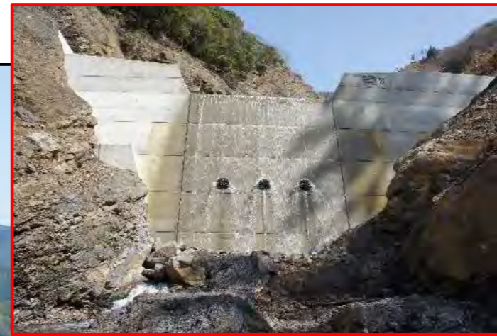
第7号谷止工 完成状況
