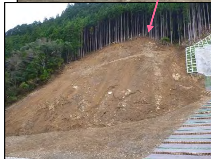
法切工 完成状況
