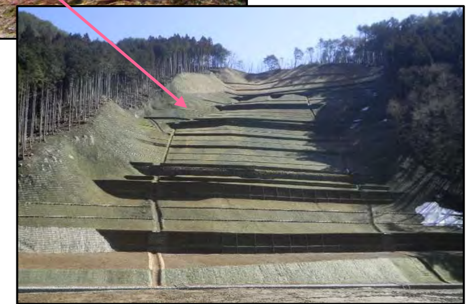
植生マット伏工、丸太筋工 完成状況
