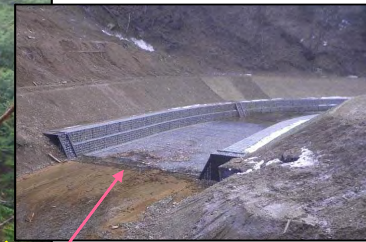
流路工 完成状況
