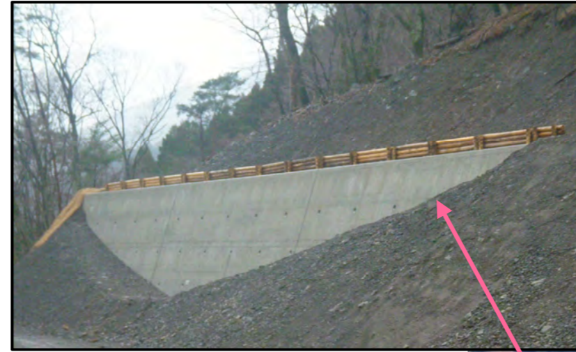
第1号土留工 完成状況
