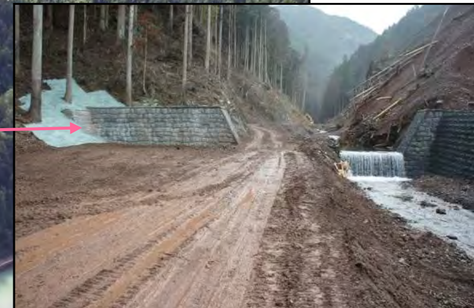
第2号床固工 完成状況
