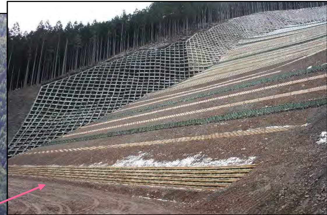
木製ブロック土留工、法枠工 完成状況
