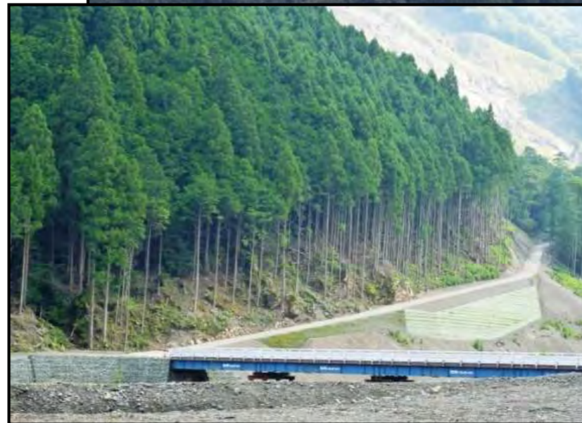
作業道 完成状況
