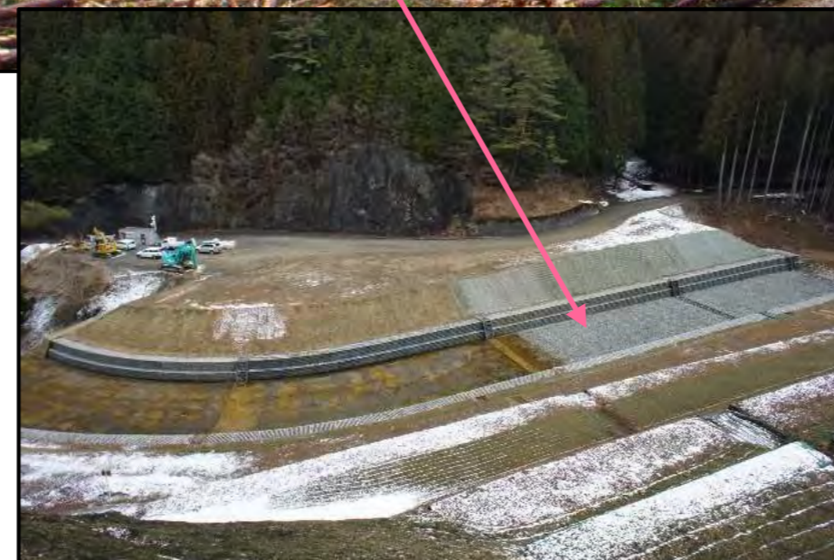
流路工 完成状況
