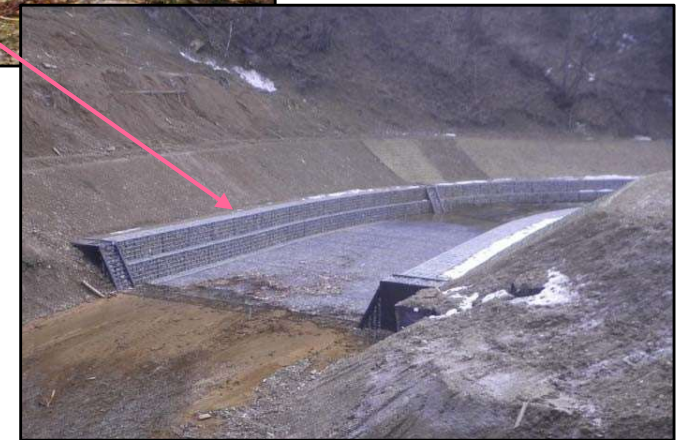
流路工 完成状況
