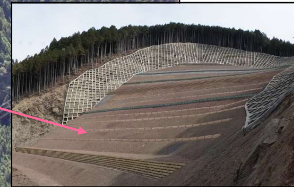
山腹工 完成状況
