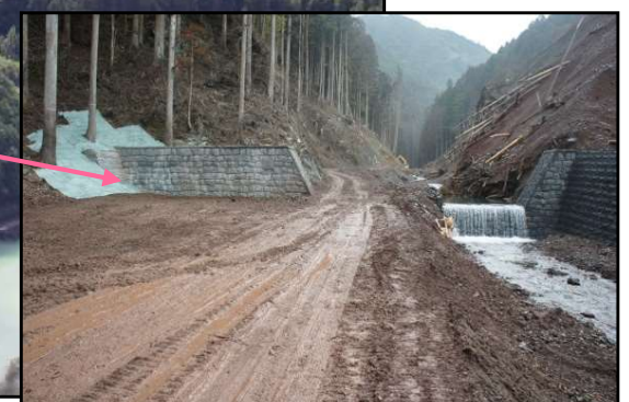
第2号床固工 完成状況
