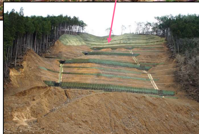
鋼製棒土留工、筋工、水路工 完成状況
