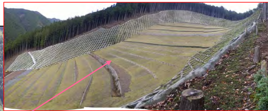
H30年度 完成状況
