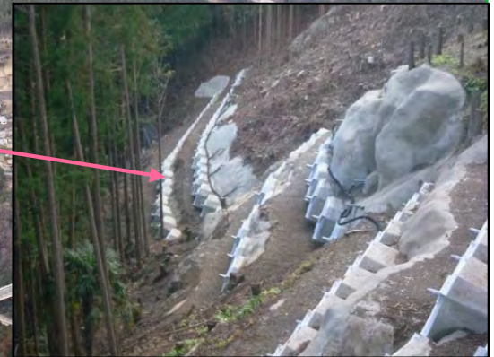
アンカー工 完成状況
