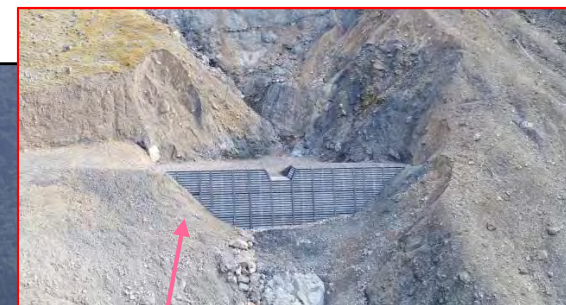
2号土留工 完成状況
