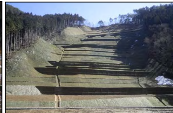
山腹工 H28完成状況
