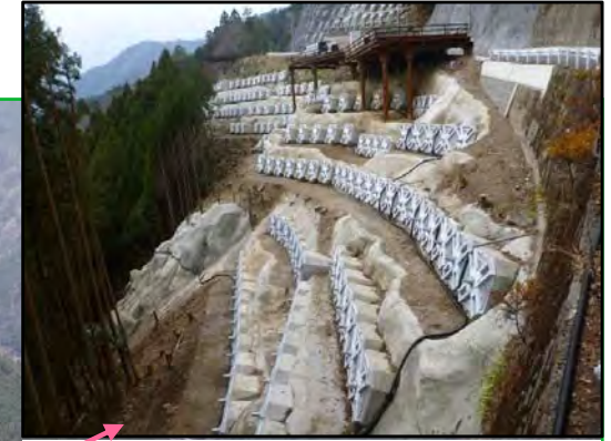
アンカー工 完成状況
