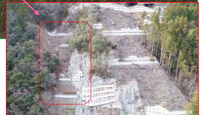
完成状況 上空から
