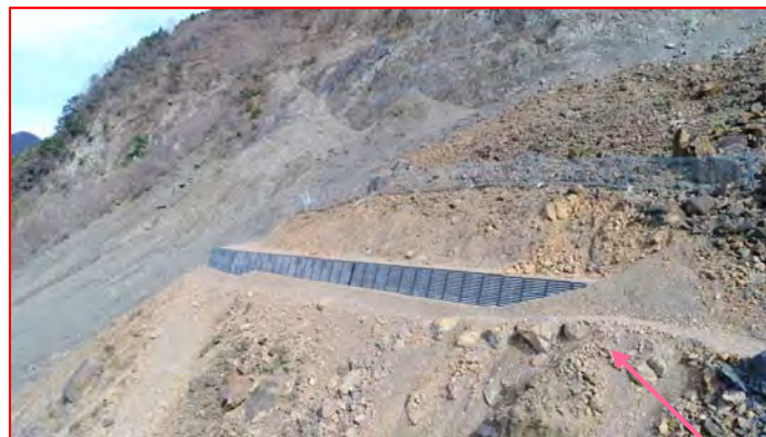
5号鋼製棒土留工 施工状況
