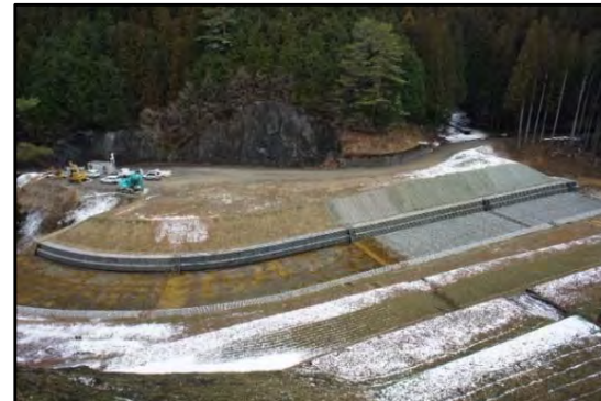
流路工 H28完成状況
