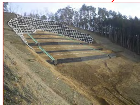
H30年度 完成状況
