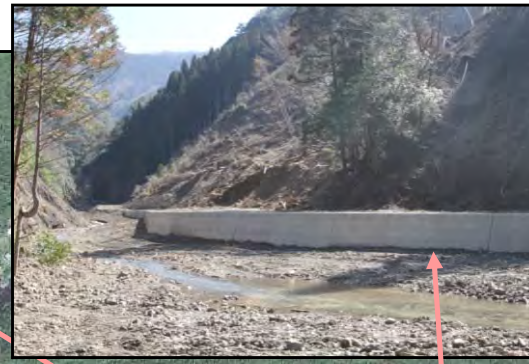
護岸工 完成状況
