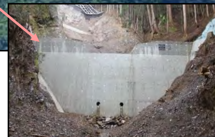
第2号谷止工 完成状況
