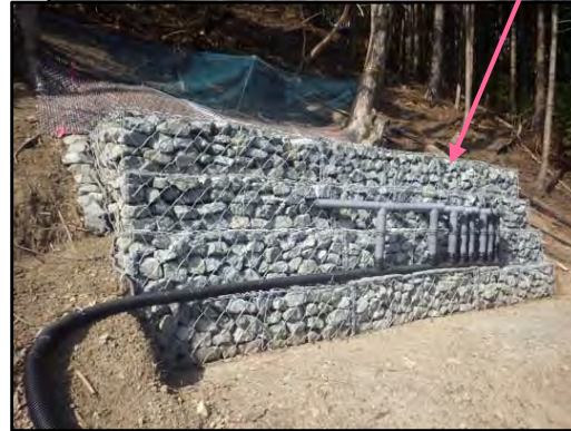
排水ボーリング工 完成状況
