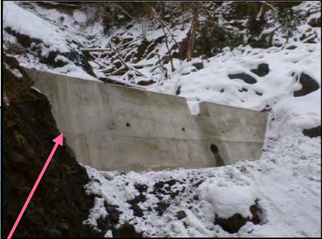
第2号土留工 完成状況
