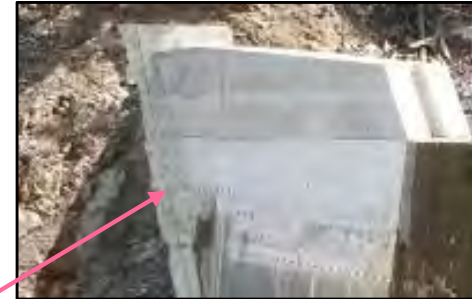
第4号谷止補修工 完成状況
