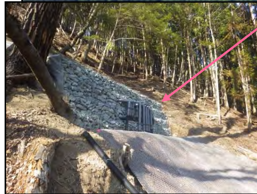
排水ボーリング工 完成状況
