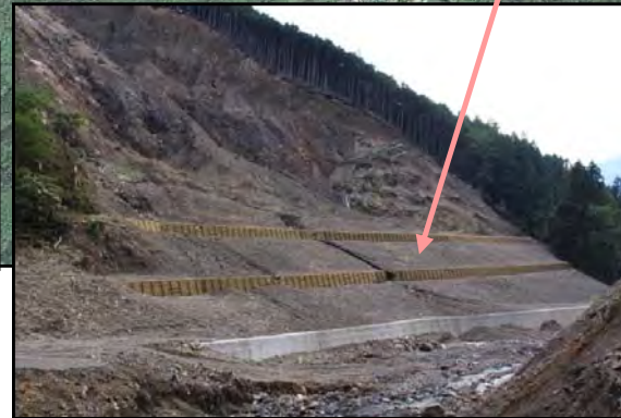
木製土留工 完成状況
