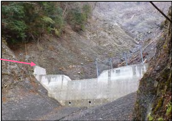
第4号谷止工 完成状況
