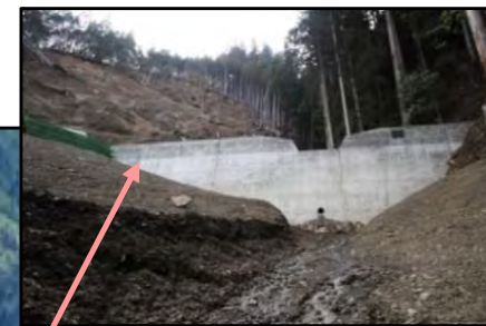
第6号谷止工 完成状況
