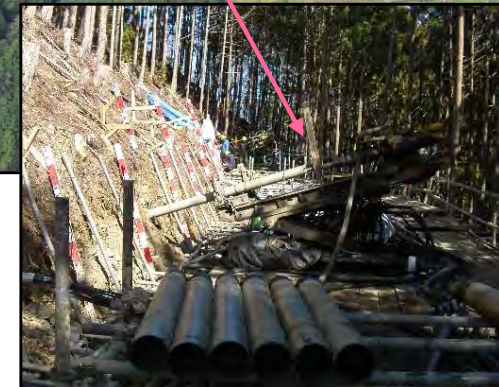
アンカー工 施工状況
