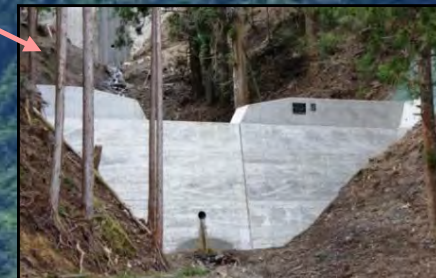
第4号谷止工 完成状況
