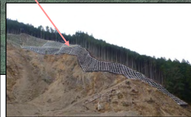
法枠工 完成状況
