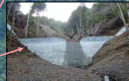
第5号谷止工 完成状況
