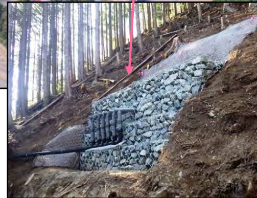
排水ボーリング工 完成状況
