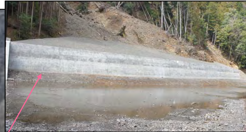
護岸工 完成状況
