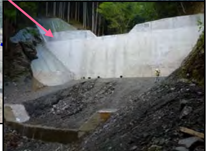
第2号谷止工 完成状況
