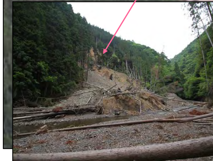
山腹崩壊の状況
