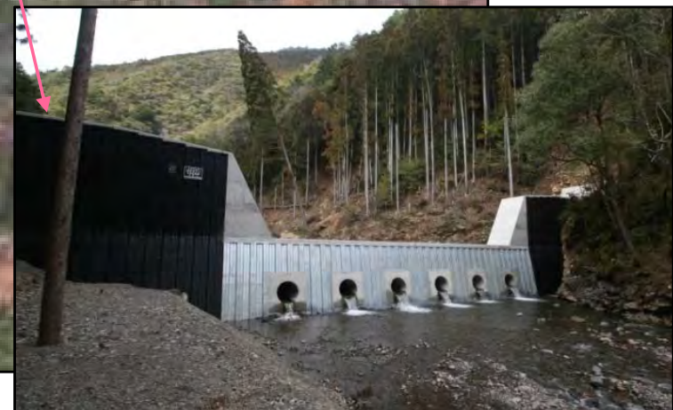
鋼製谷止工 完成状況
