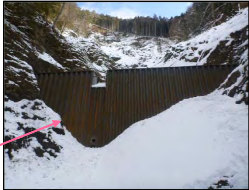
第1号土留工 完成状況
