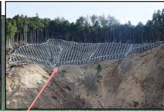
法枠工 完成状況
