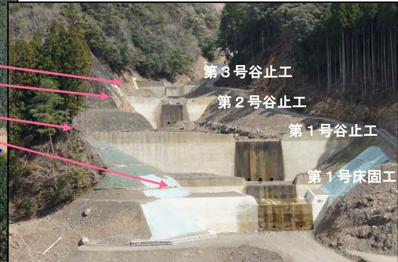
第1~3号谷止工 第1号床固工 完成状況
