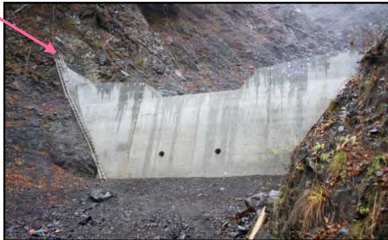
第3号谷止工 完成状況
