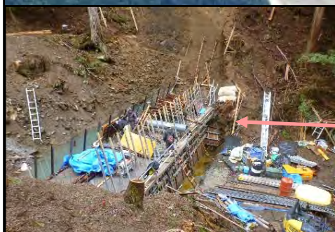
第3号谷止工 施工状況
