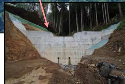
第1号谷止工 完成状況
