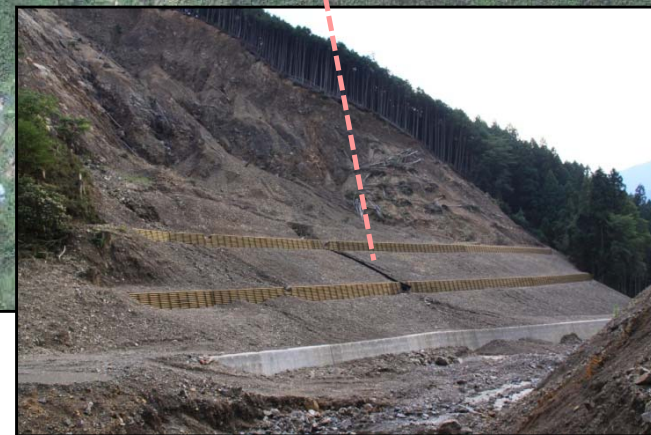
木製土留工 完成状況
