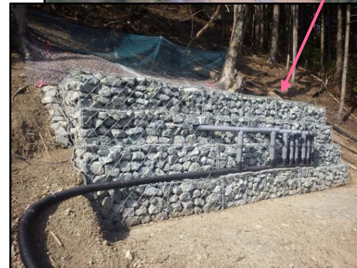
排水ボーリング工 完成状況
