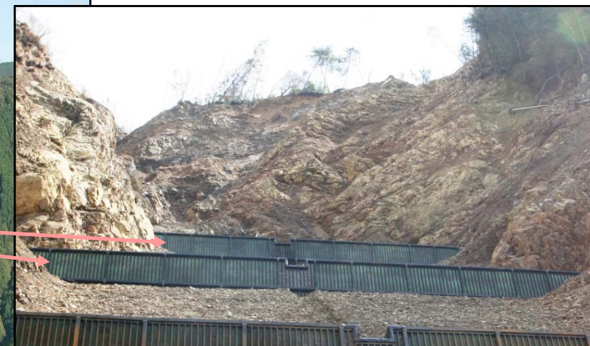
3号、4号鋼製土留工 完成状況
