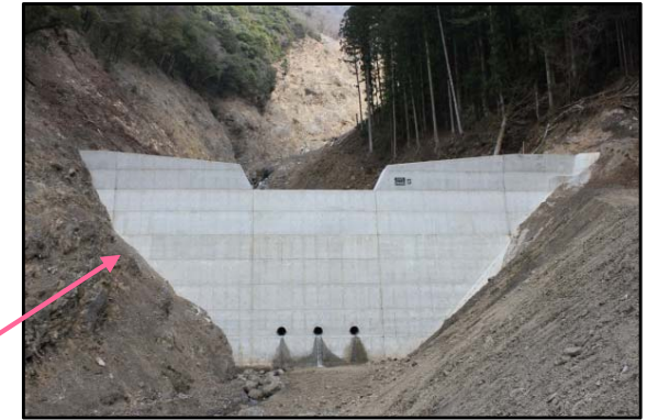
第5号谷止工 完成状況
