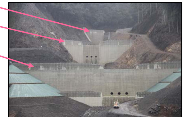
第1～3号谷止工 完成状況
