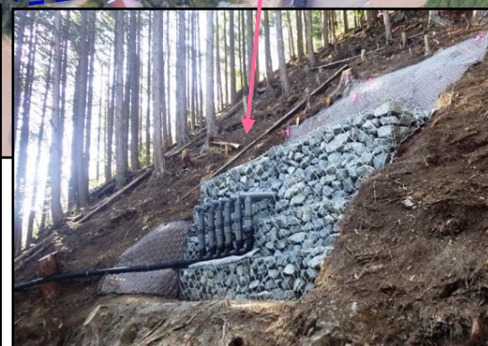
排水ボーリング工 完成状況
