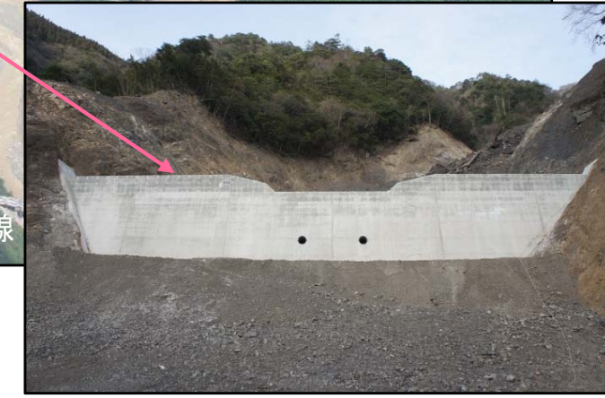
第2号谷止工 完成状況
