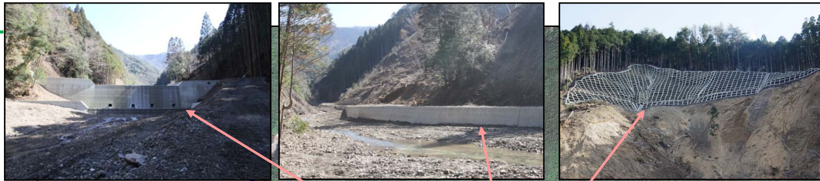
第2号谷止工 完成状況
