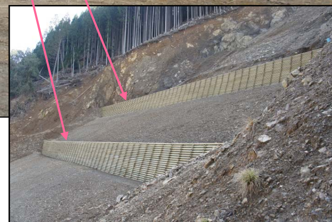
木製土留工 完成状況
