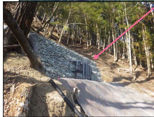
排水ボーリング工 完成状況
