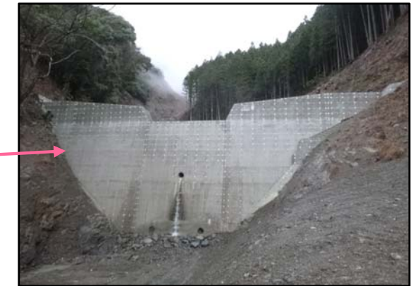
第4号谷止工 完成状況
