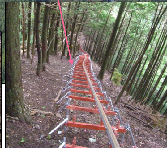
仮設モノレール設置完了
