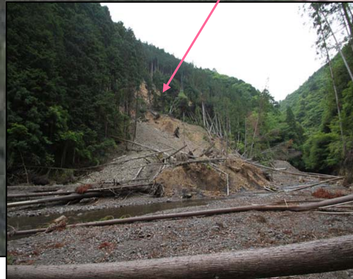
山腹崩壊の状況
