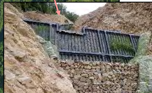
5号鋼製土留工 完成状況
