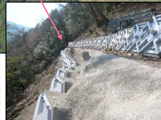
10・11段目アンカー工 完了状況
