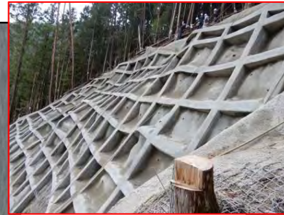
現場吹付法砕工(近景)
