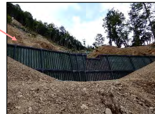
7号、8号鋼製土留工 完成状況
