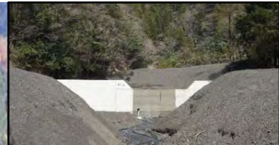
第3号谷止工 H29完成状況
