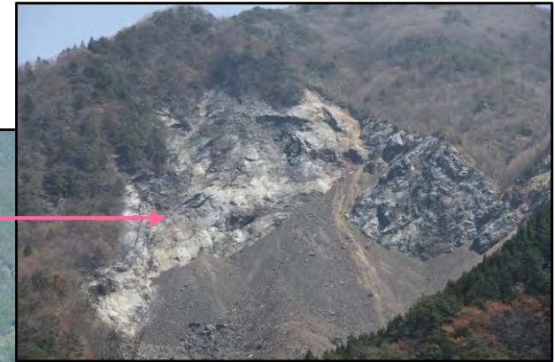
航空緑化工(モルタル吹付) 完成状況
