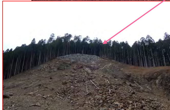
H30 法砕工施工完了の状況
