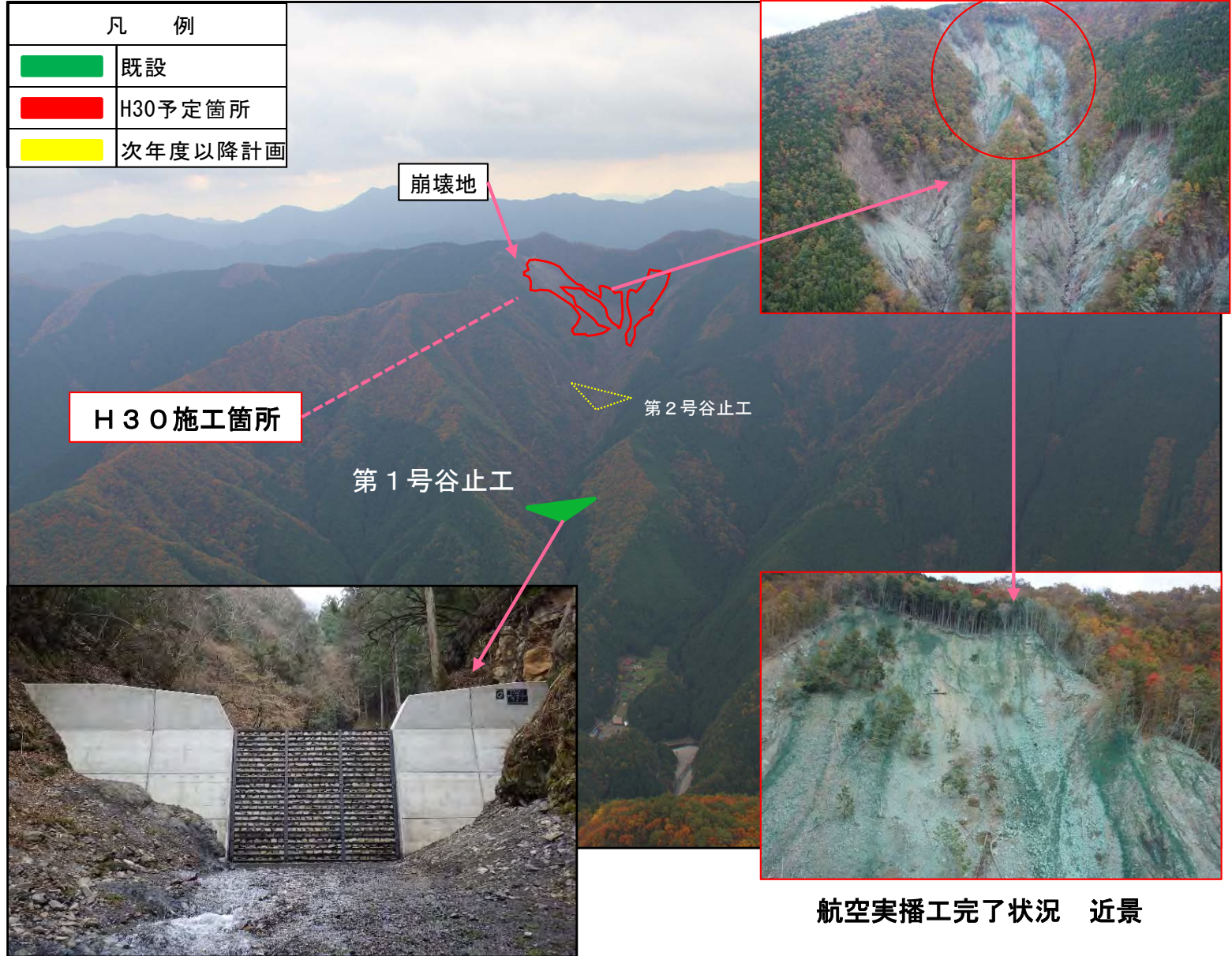
第1号谷止工 完成状況
