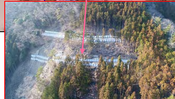
アンカー工 施工状況 (近景)
