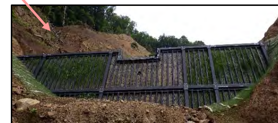
6号鋼製土留工 完成状況
