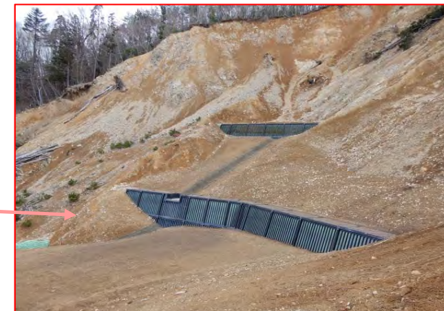
10・11号かご枠土留工 完成状況
