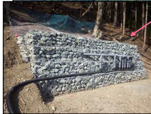
排水ボーリング工 完成状況
