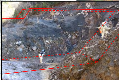
第4号谷止工 掘削状況 (H31.3)
