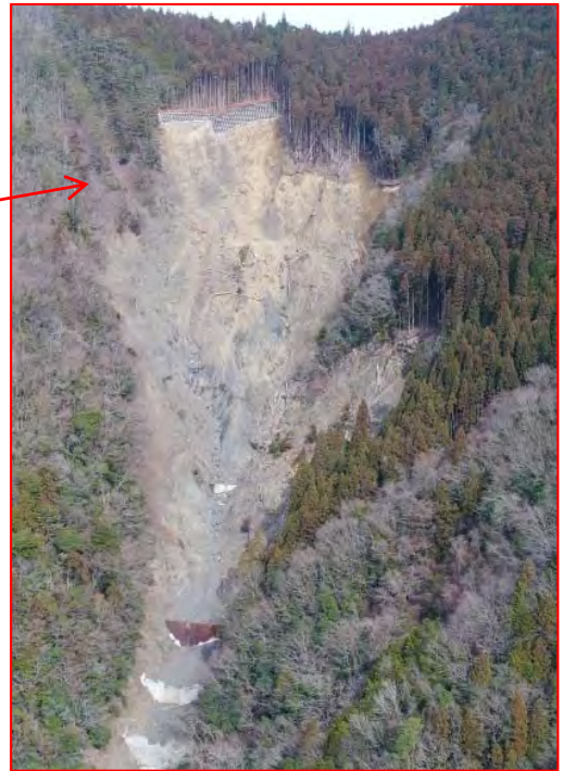
山腹工全景 上空から
