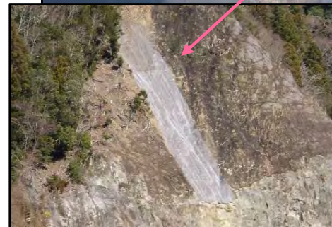
法面保護工 完成状況
