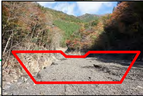
第4号谷止工 施工箇所状況 (計画時)
