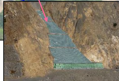
法面保護工 完成状況
