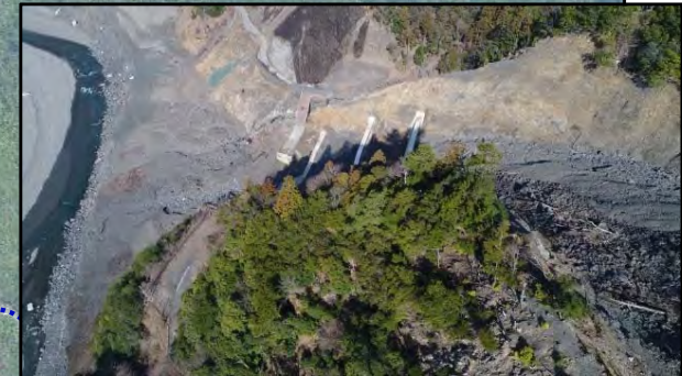
第2-1号谷止工 施工箇所状況
