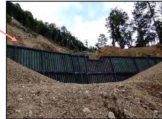
7号、8号鋼製土留工 完成状況
