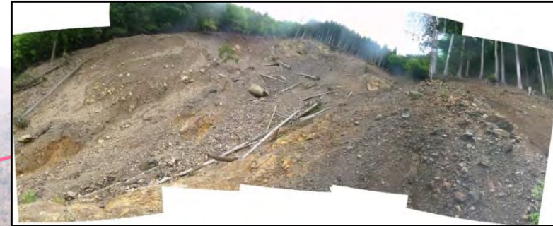
3号地 崩壊状況
