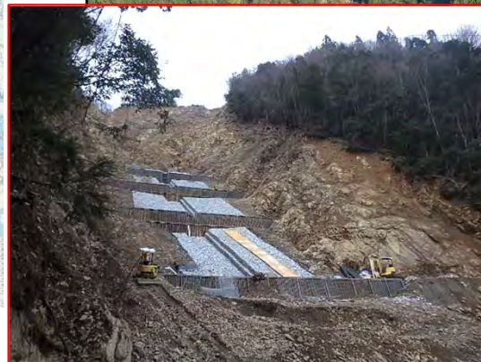
5号鋼製土留工 完成状況
