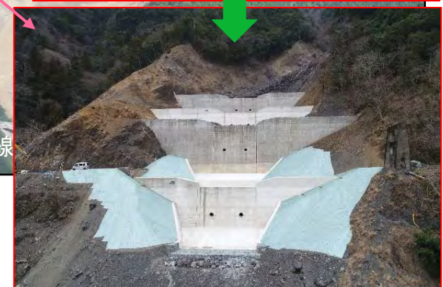
副堤及び本堤完成状況
