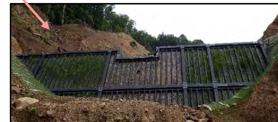
6号鋼製土留工 完成状況
