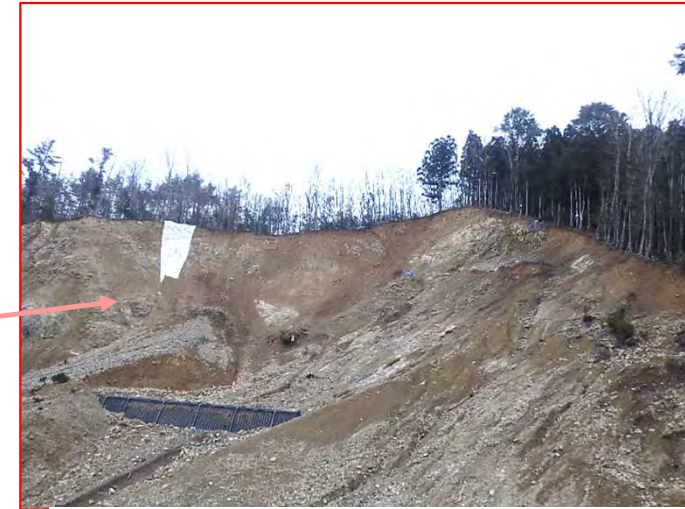
今年度 斜面安定工施工状況
