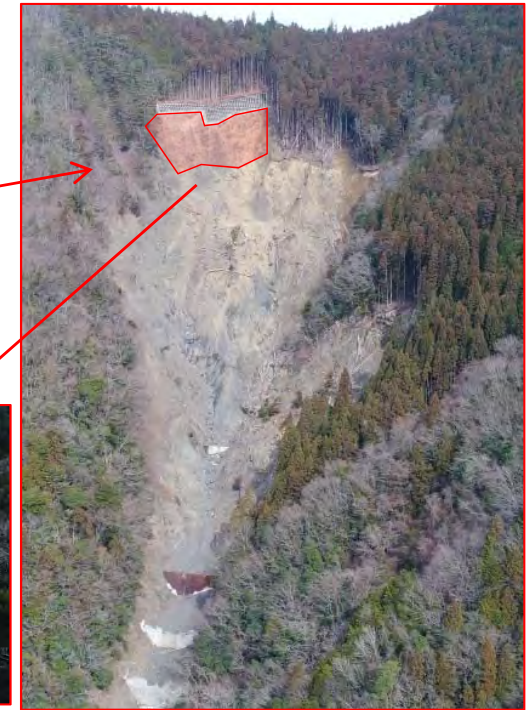
山腹工計画箇所 上空から
