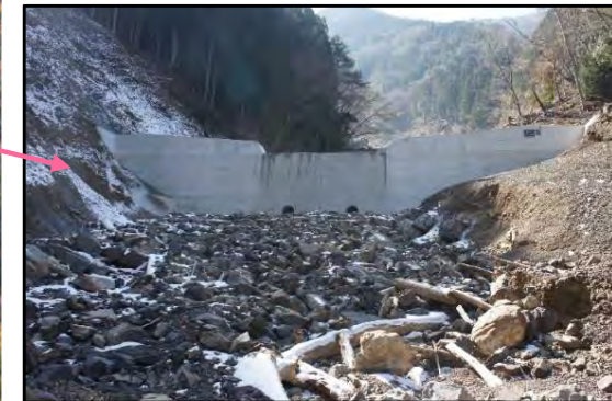
H29 第3-1谷止工 完成状況
