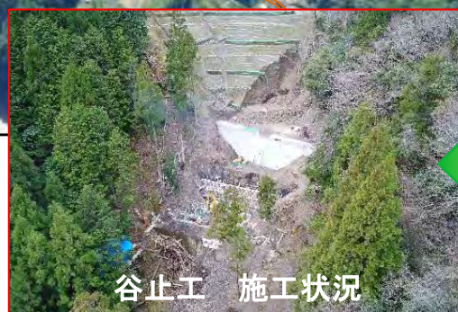
山腹工(1号地)・第1号谷止工 完成状況
