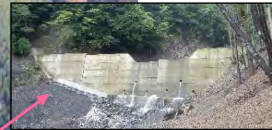
第3号谷止工 補修状況
