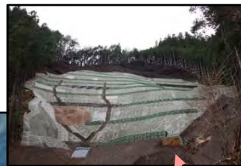
山腹工(2号地) 完成状況
