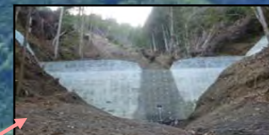
第5号谷止工 完成状況
