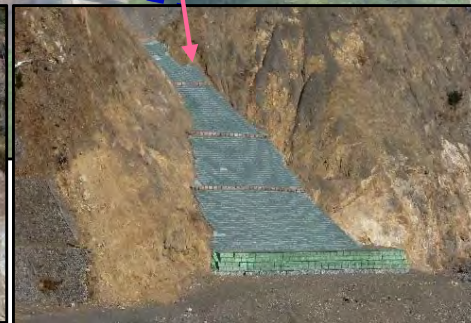
法面保護工 完成状況
