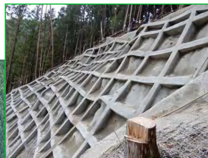
現場吹付法砕工(近景)
