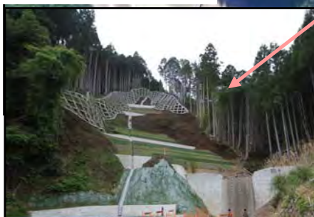
山腹工(1号地)・第1号谷止工 完成状況
