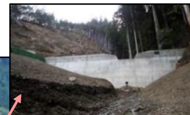
第6号谷止工 完成状況
