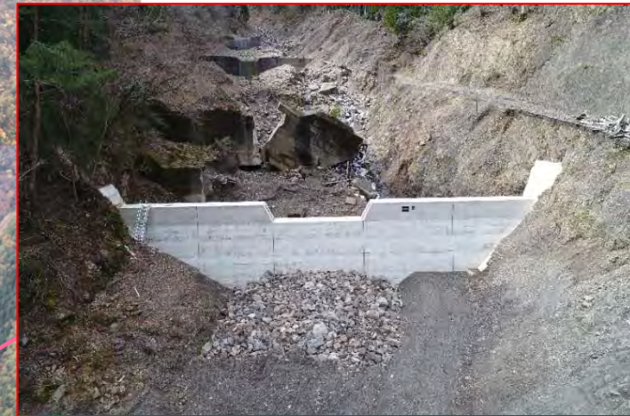
2-1号副ダム 完成状況
