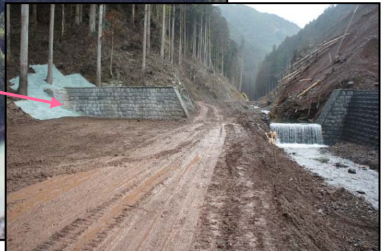
第2号床固工 完成状況
