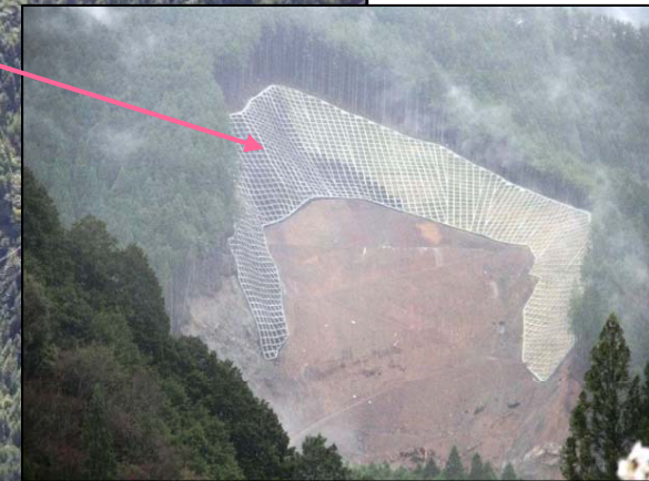
法枠工 完成状況
