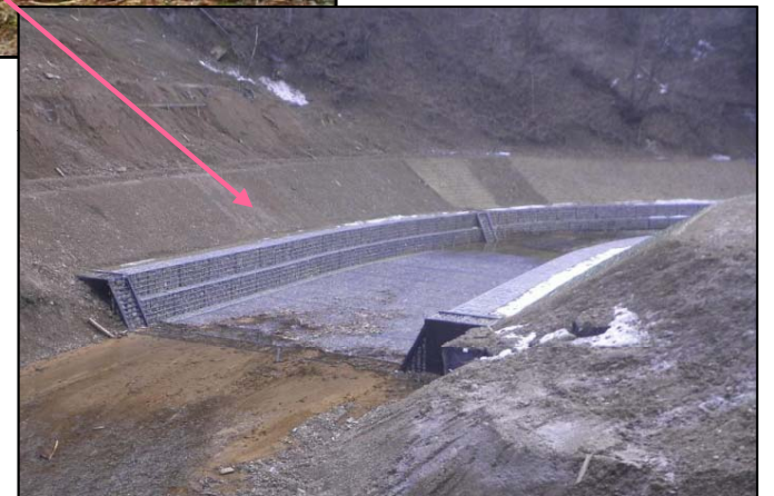
流路工 完成状況
