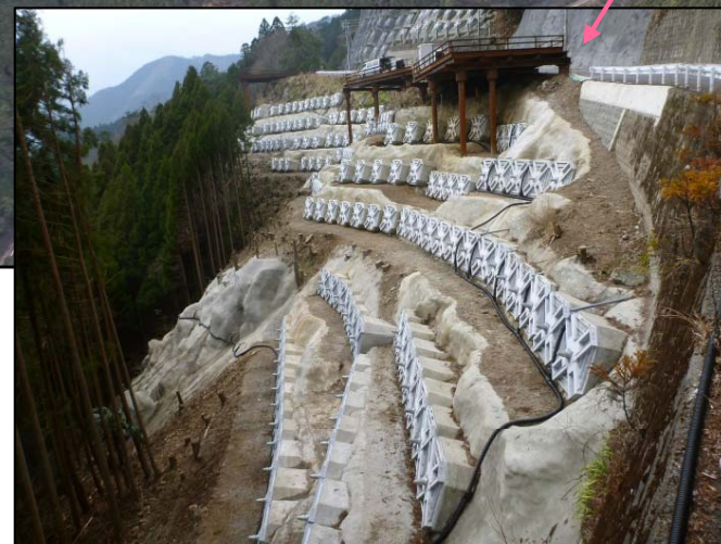
アンカー工 完成状況
