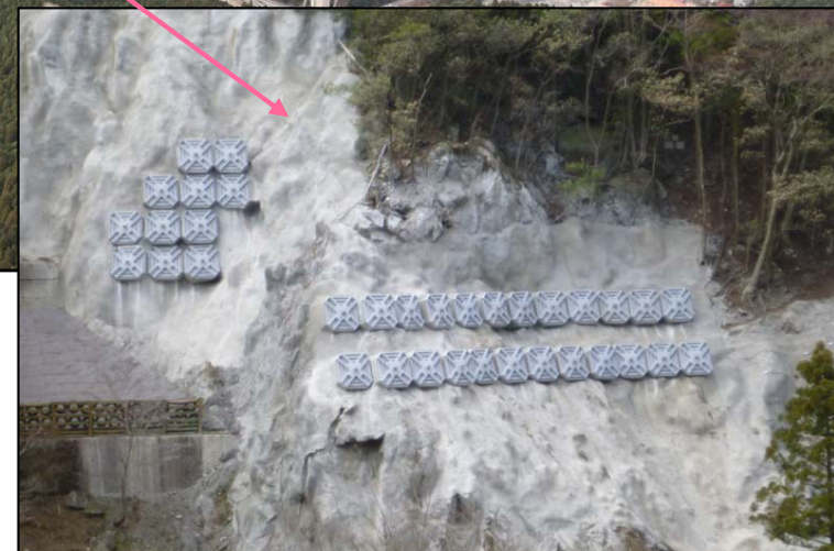
アンカー工 完成状況
