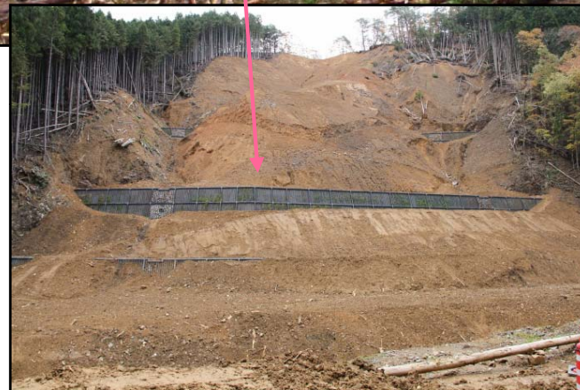
鋼製枠土留工 完成状況
