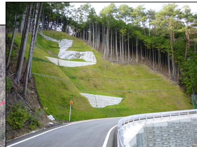
山腹工 完成状況 (村道上部)
