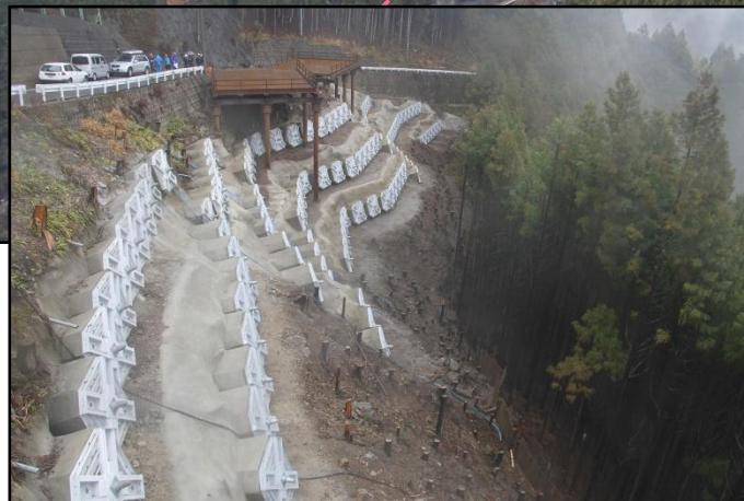
アンカー工 完成状況
