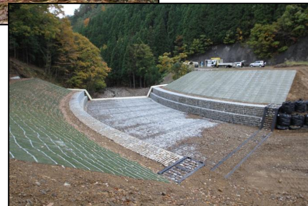
流路工 完成状況
