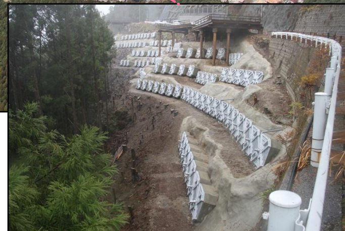
アンカー工 完成状況
