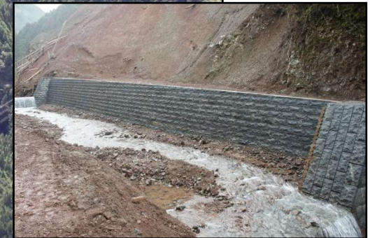
護岸工 完成状況
