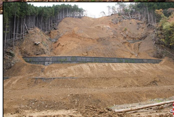
鋼製枠土留工 完成状況
