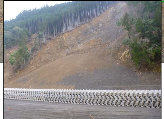
コンクリートブロック製作 完成状況
