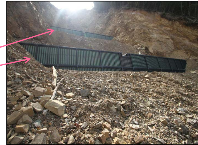
1号、2号鋼製砕土留工 完成状況
