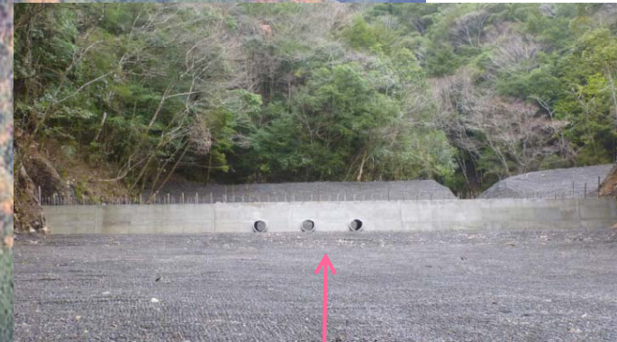
第1号谷止工完成状況
