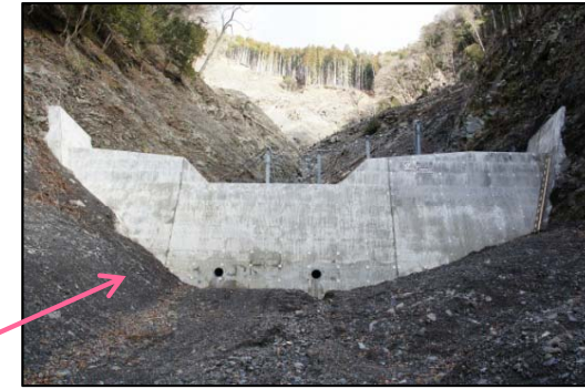
第4号谷止工 完成状況
