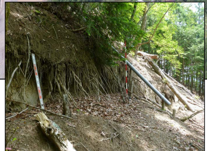
施工地内の地すべり亀裂状況
