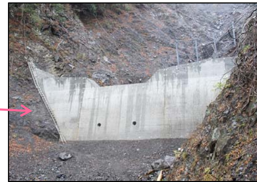
第3号谷止工 完成状況
