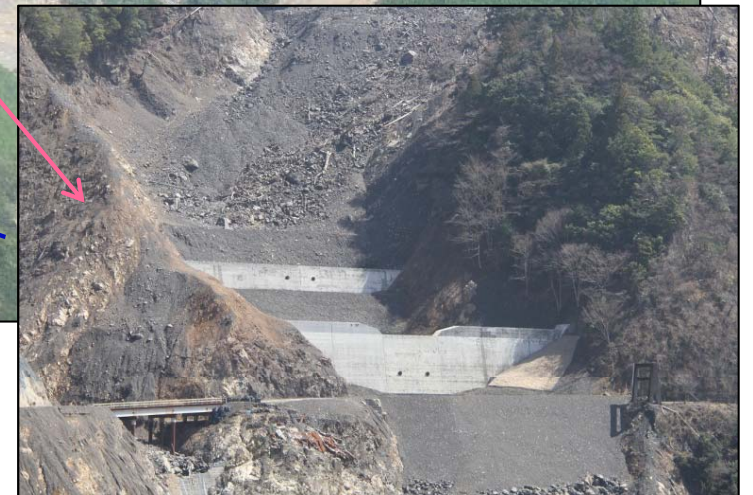
第1号谷止、第2号谷止 完成状況
