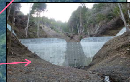
第5号谷止工 完成状況
