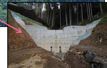
第1号谷止工 完成状況
