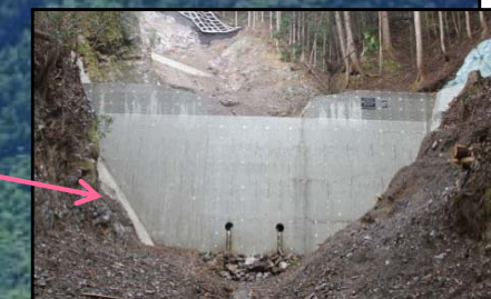
第2号谷止工 完成状況
