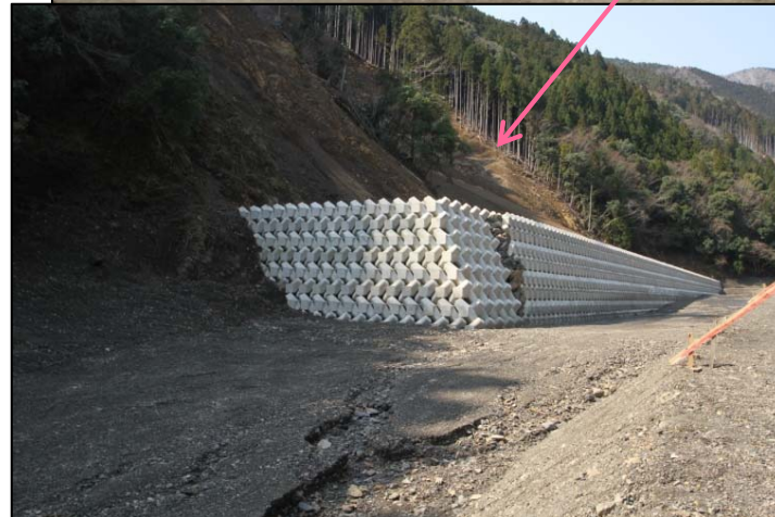
コンクリートブロック護岸工 完成状況
