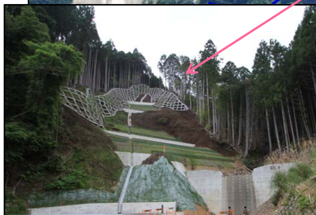
山腹工 完成状況
