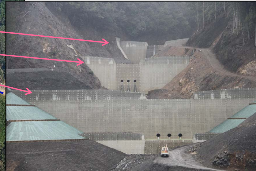
第1～3号谷止工 完成状況
