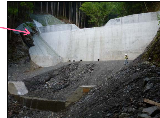
第2号谷止工 完成状況
