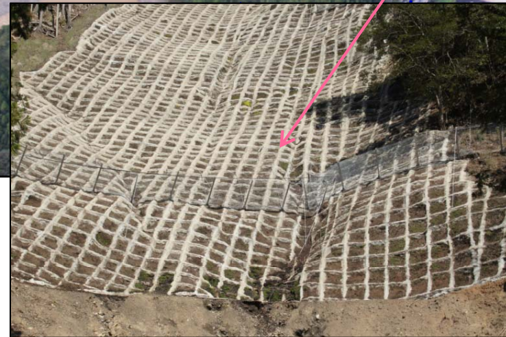
安全対策工 完成状況
