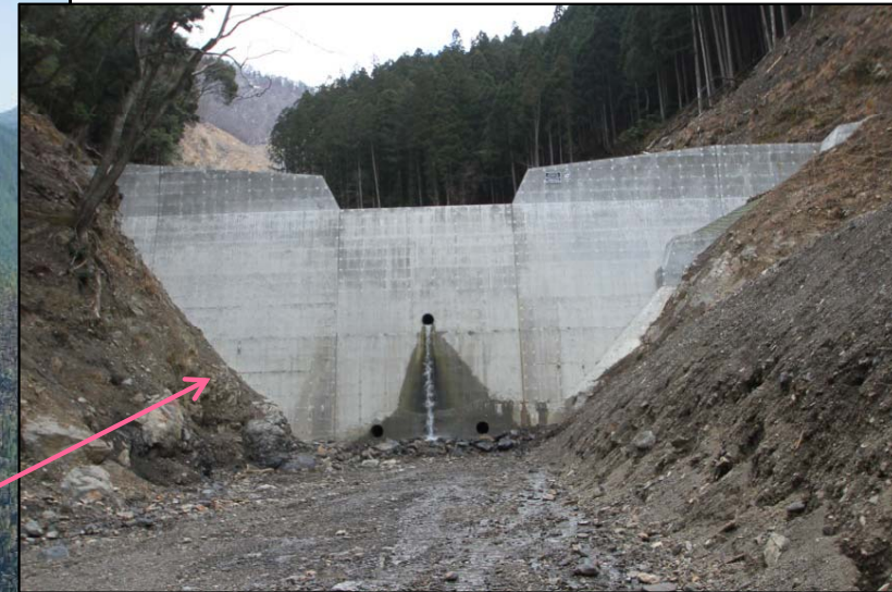
第4号谷止工 完成状況
