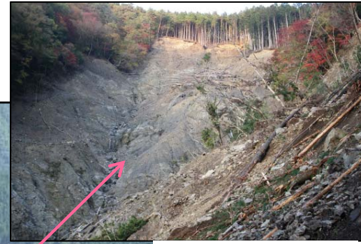
山腹法面の状況
