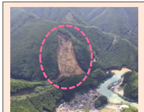
坪内工区(被災直後) ・崩壊規模 3.65ha ・対策: 床固工及び山腹工
