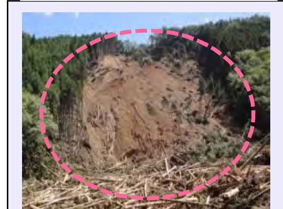
檜股工区(被災直後) ・崩壊規模 1.56ha ・対策: 谷止工及び山腹工 (令和3年度工事完了・移管済)
