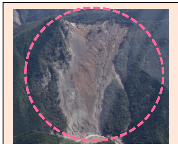
赤谷工区(被災直後) ・崩壊規模 24.86ha ・対策: 山腹工及び土留工
