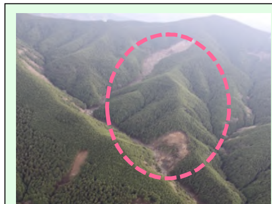
栃尾(桑谷)工区(被災直後) ・崩壊規模 1.5ha ・対策: 谷止工及び山腹工 (令和3年度工事完了)
