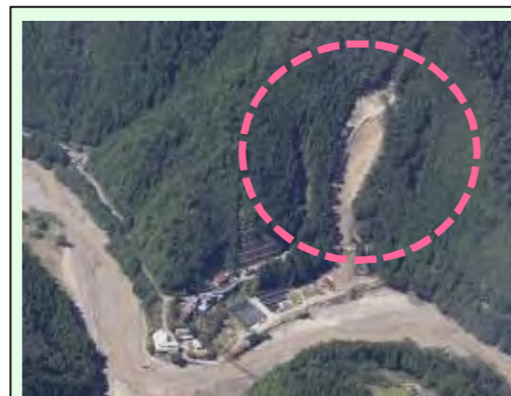
五百瀬工区(1号地) (被災直後) ・崩壊規模 0.47ha ・対策：山腹工 (令和4年度工事完了)
