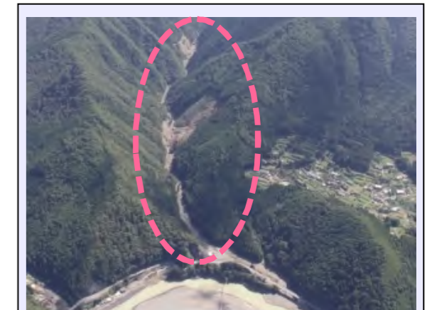
高津工区 (被災直後) ・崩壊規模 2.67ha ・対策：谷止工、山腹工 (平成30年度工事完了・移管済)
